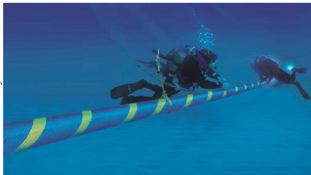
**Fig. 17a, 17b - Sezione del cavidotto marino di collegamento al collettore e posa sul fondale.**
