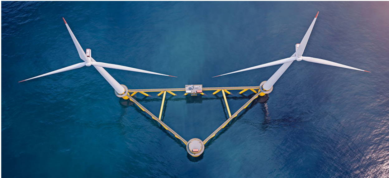
Figure 7/8 – Struttura di fondazione galleggiante con doppio aerogeneratore
