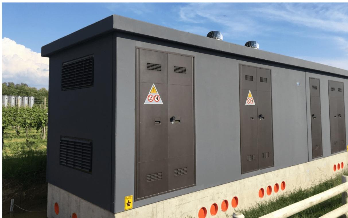
*Fig. 11 – Cabina elettrica monolitica in Ral 6002*
