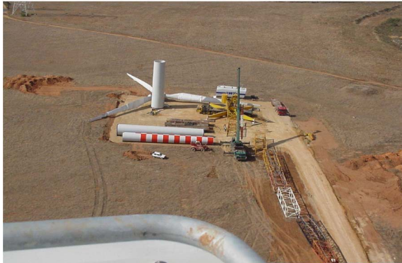
Figura 6: Piazzola per il montaggio dell'aerogeneratore
