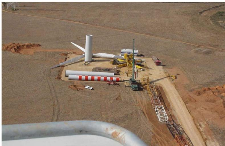
**Figura 5 : Piazzola per il montaggio dell'aerogeneratore**
