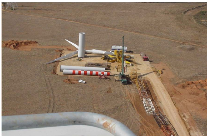
Figura 3 – Piazzola per il montaggio dell'aerogeneratore
