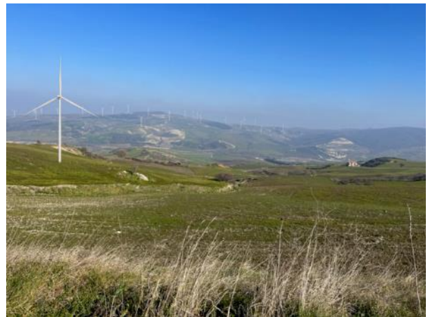
Punto di vista Mont 8 – post operam
