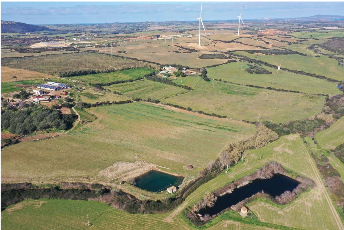
Figura 20: Stato di fatto - Lotto 2, vista da est
