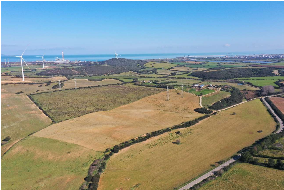
Figura 21: Stato di fatto del lotto 2, vista da sud
