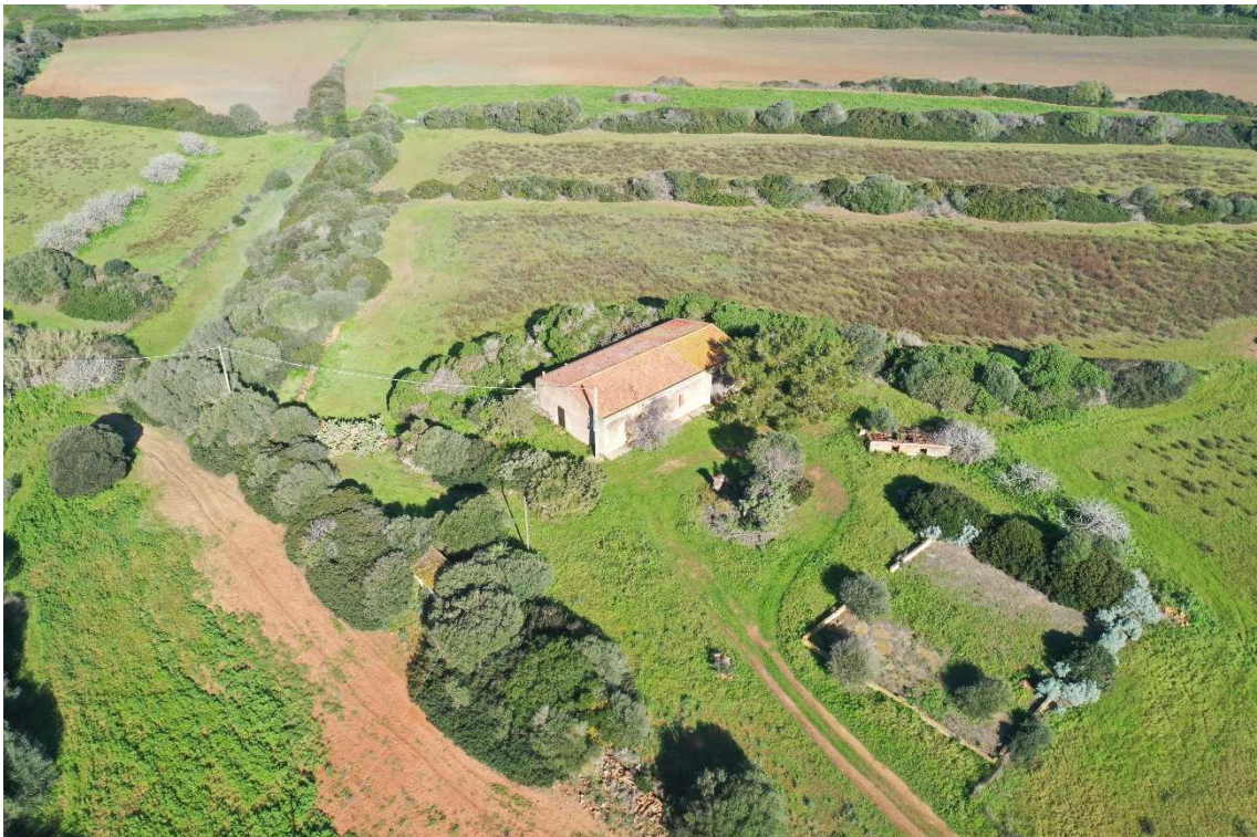
Figura 18.: Edificio da demolire nel lotto 1
