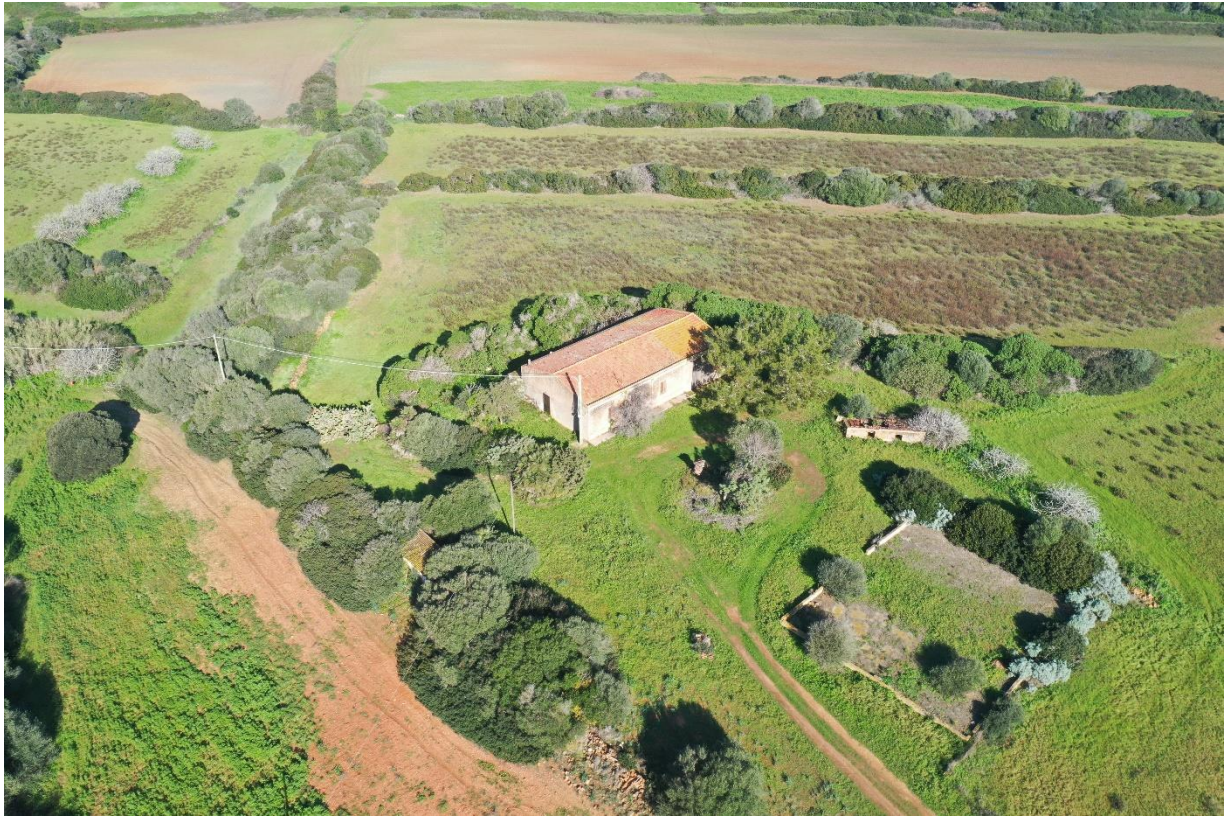
Figura 10 - Manufatto rurale da demolire – Fotografia 09
