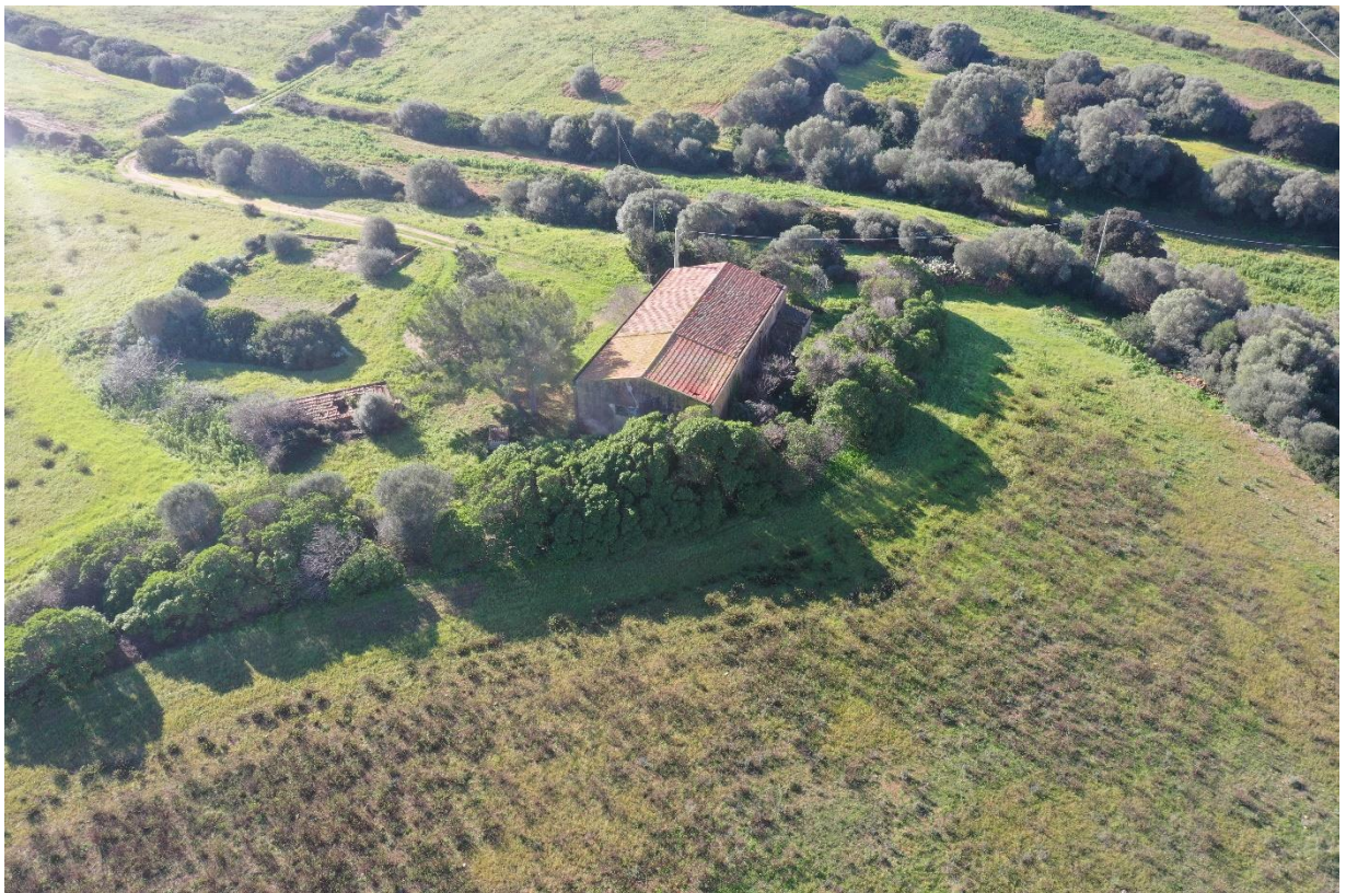
Figura 11 - Manufatto rurale da demolire – Fotografia 10
