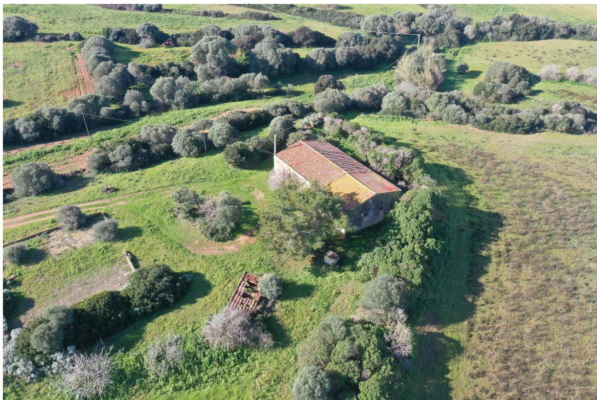
Figura 12 - Manufatto rurale da demolire – Fotografia 11
