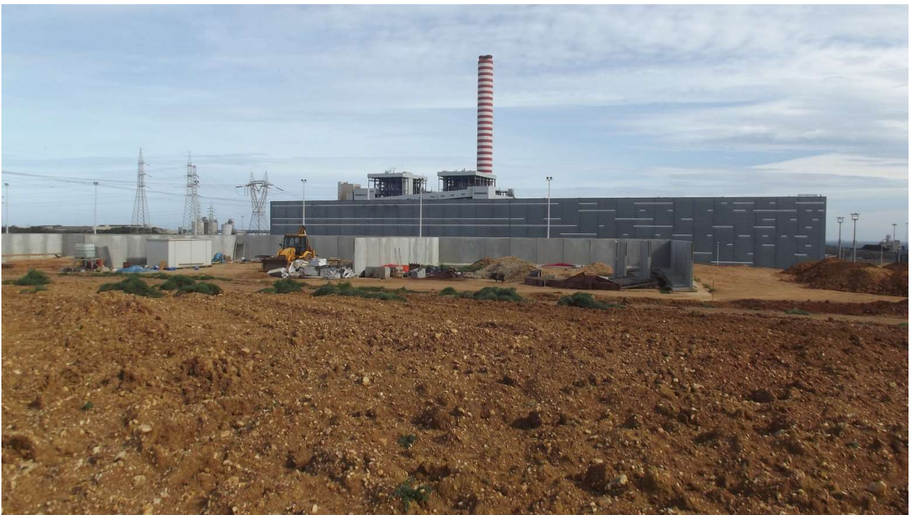
Il cantiere per i lavori della stazione elettrica Terna
