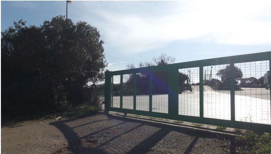
Cancello d'ingresso alla discarica (UT 2.1)
