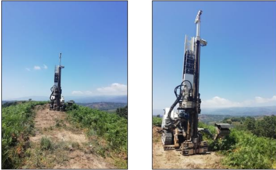
Figura 8 - Posizione sondaggio S2
