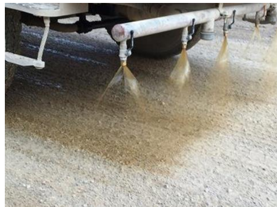
Figura 62 – Attività di cleaning vehicles e bagnatura
