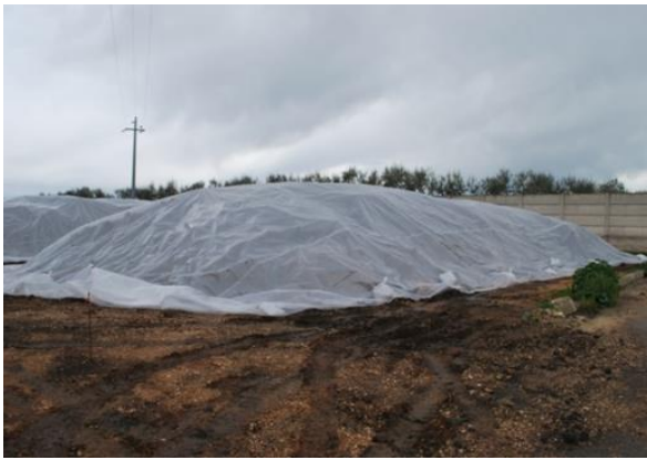
Figura 61 - Teli antipolvere
