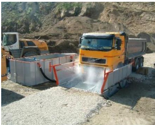
Figura 62 – Attività di cleaning vehicles e bagnatura
