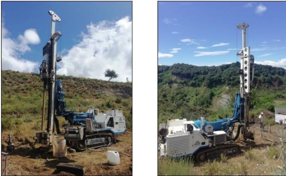
Figura 10 - Posizione sondaggio S3
