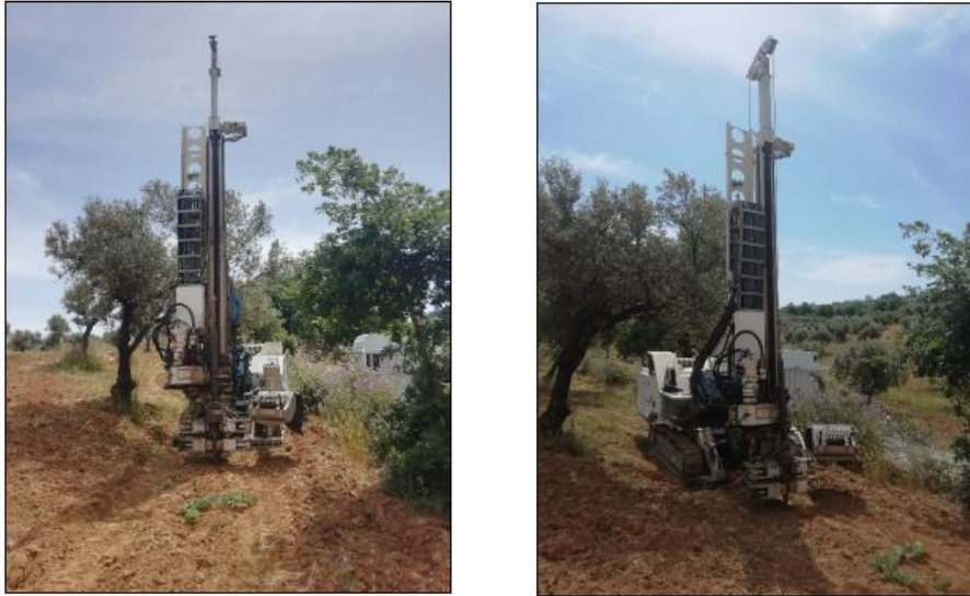
Figura 6 – Posizione sondaggio S1
