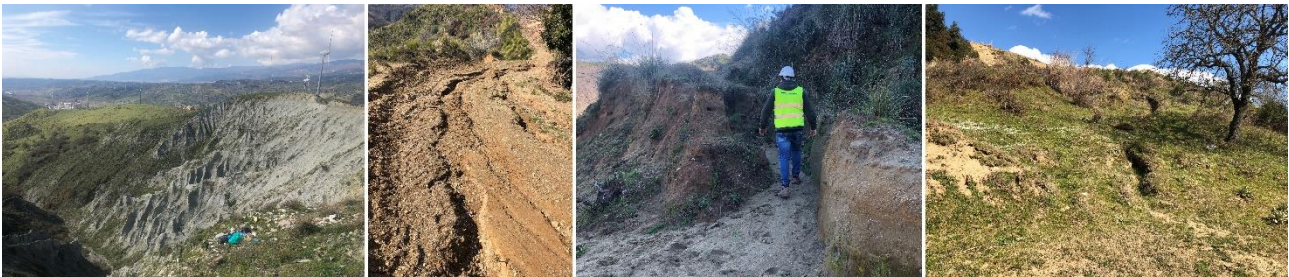
Figura 9 - Evidenze di fenomeni erosivi.
