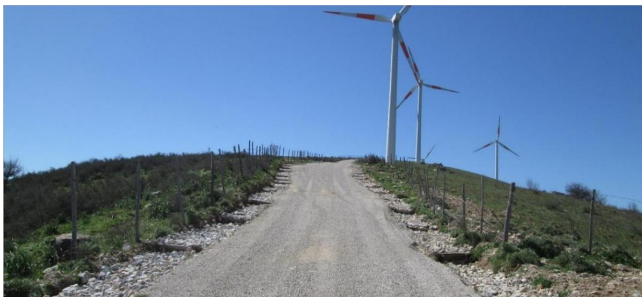
Figura 15 - Esempio di sistema di fossi di guardia con fondo rivestito in pietrame e salti.
