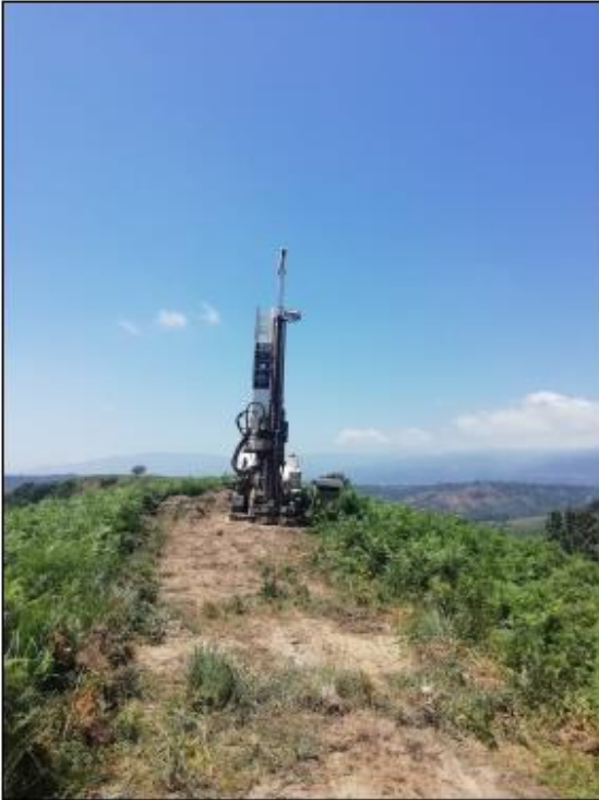
Foto n.1 _Ubicazione Sondaggio geognostico S2
