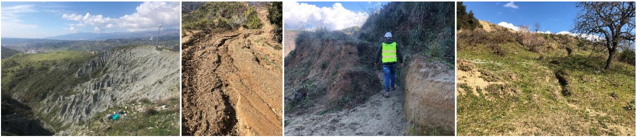
Figura 11 - Evidenze di fenomeni di erosivi.
