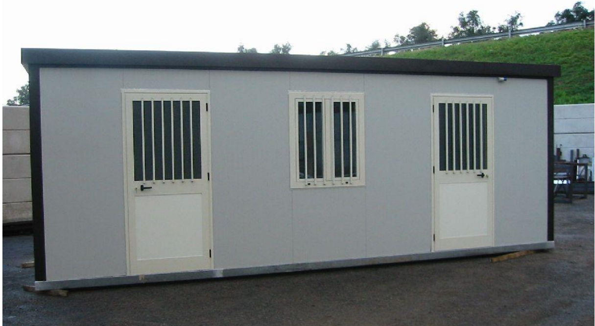
Figura 17 - Esempio di Baraccamento
