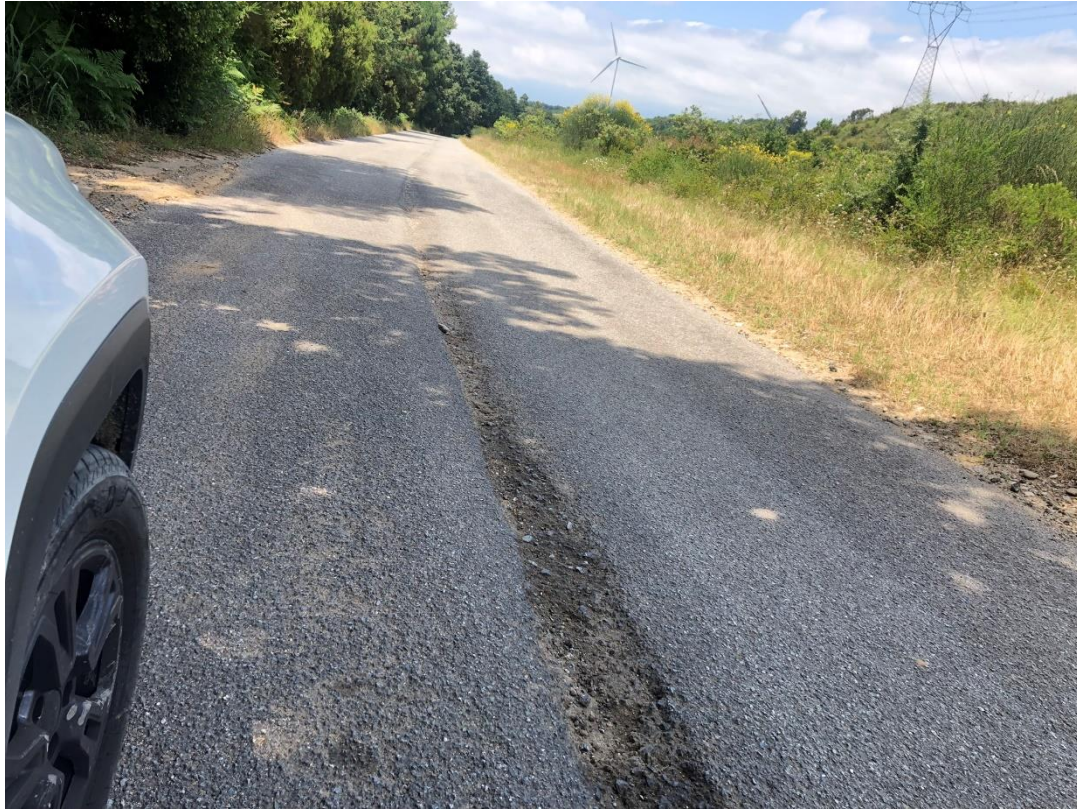
CAVIDOTTO SU VIABILITÀ COMUNALE ESISTENTE
