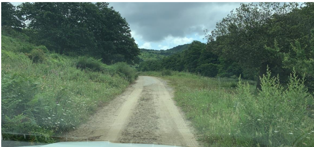
Figura 13 – Foto tipologia di strada esistente in area parco
