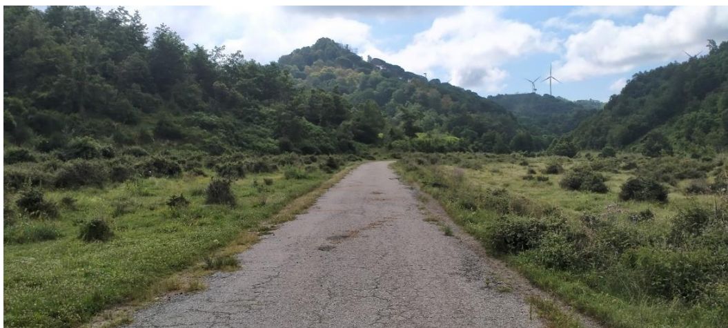
Figura 12 - Foto tipologia di strada esistente in area parco
