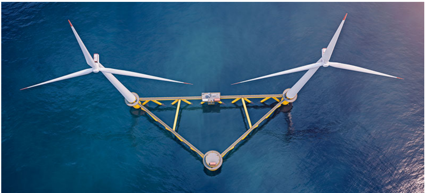
Figure 18/19 – Struttura di fondazione galleggiante con doppio aerogeneratore
