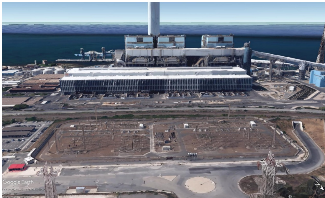
Figura 32 – Immagine della SE 380 kV Torrevaldaliga a Civitavecchia di proprietà di Terna.
