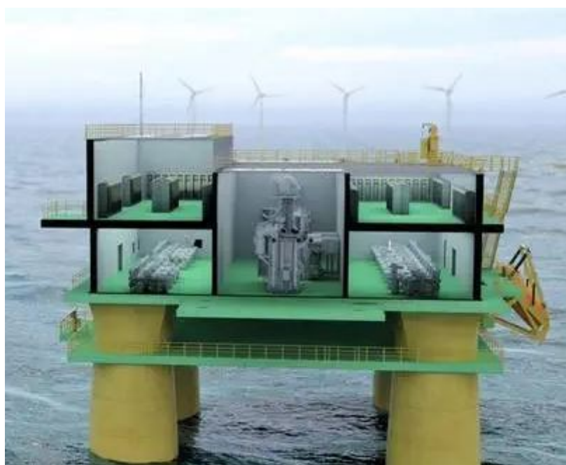
Figure 24/25/26 – Esempio di Stazione HVDC di trasformazione 150/500 kV.
