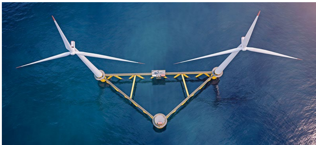
Fig. 6a, 6b – Schema funzionale del collegamento elettrico e vista di una struttura con coppia di aerogeneratori.
