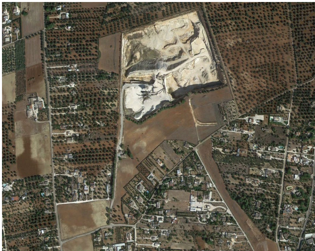
Figura 3-1 Foto aerea dello stato attuale dei luoghi
