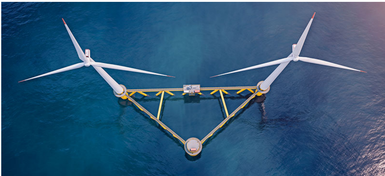
Figure 6/7 – Struttura di fondazione galleggiante con doppio aerogeneratore
