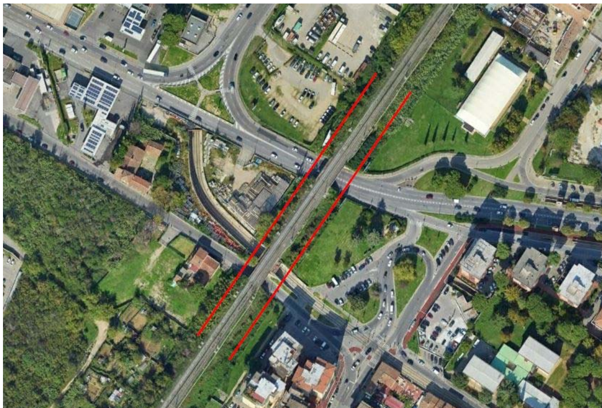
Figura 6-1 Aree verdi adiacenti ai binari soggette alle attività di lavorazione di cantiere
