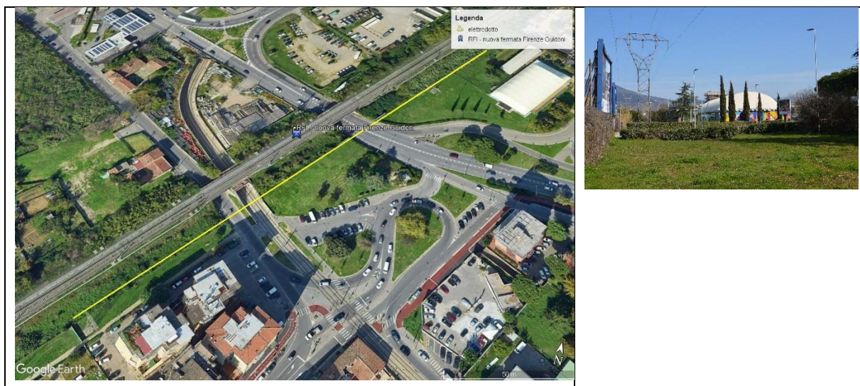
Figura 6.27: Elettrodotto presente nella zona della futura fermata
