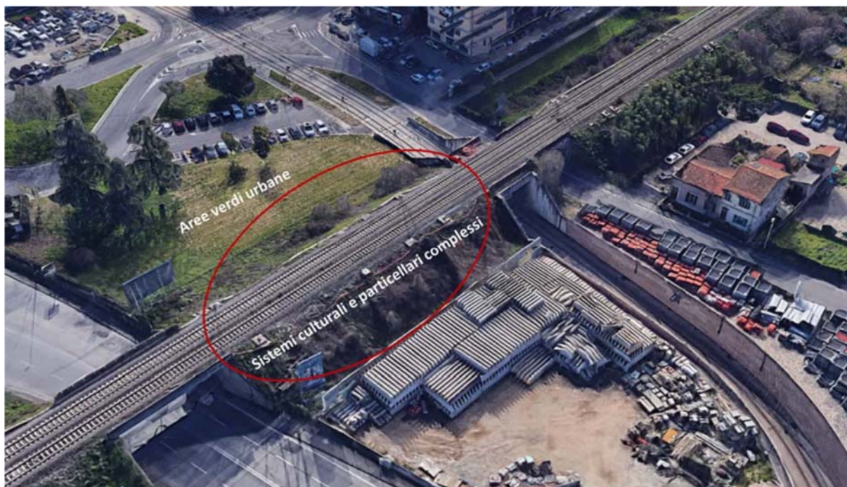
Figura 5-39: Area dove verrà realizzata la fermata. Vista dall'alto
