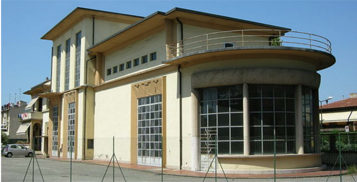
Figura 5.59: Sottostazione elettrica di Peretola
