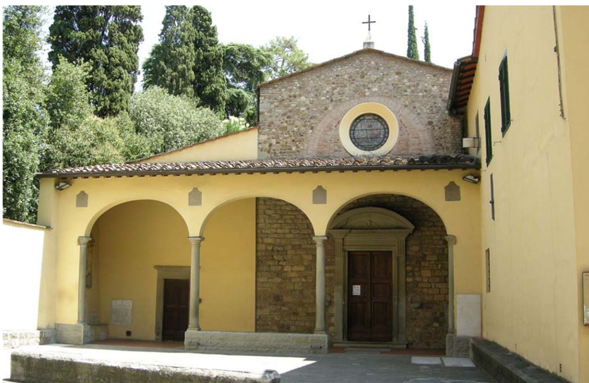
Figura 5.56: Chiesa di Santa Maria a Novoli
