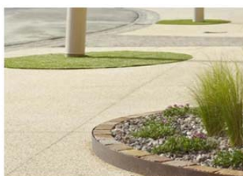
Pavimentazione esterna in graniglia drenante
