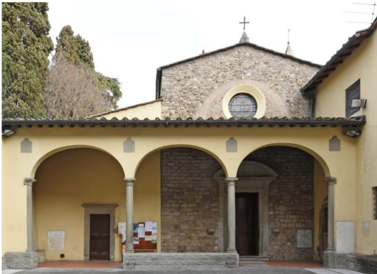
Figura 4-29: Chiesa di Santa Maria a Novoli
