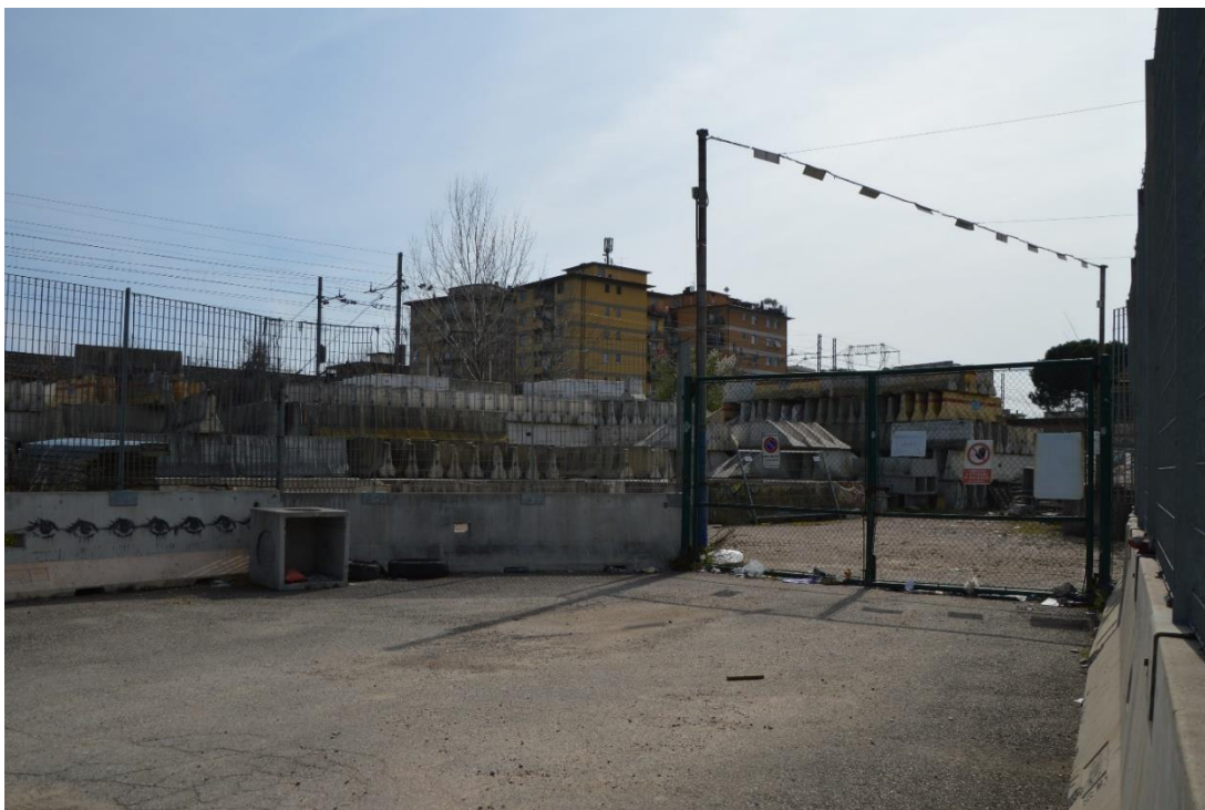
Figura 24 – Area destinata a deposito
