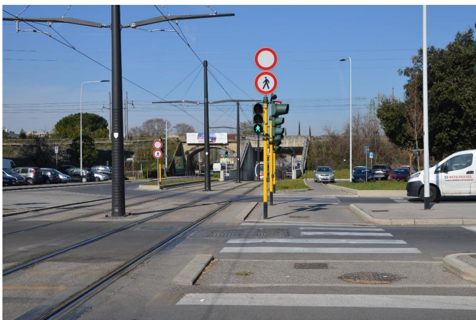
Figura 17 – Accesso pedonale al parcheggio da via Novoli
