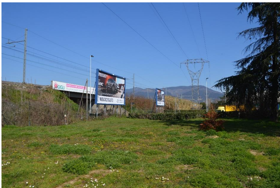
Figura 18 - Vista dell'area verde e del rilevato ferroviario
