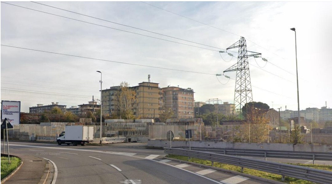
Figura 30 – Area destinata a deposito con traliccio
