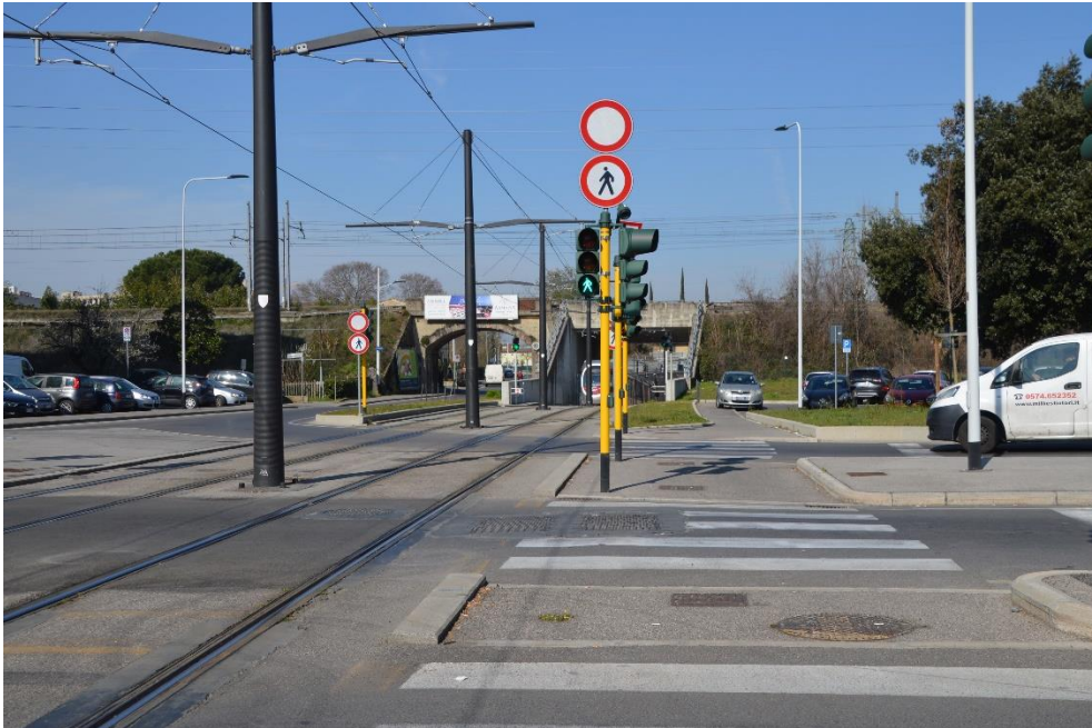
Figura 22 – Accesso pedonale al parcheggio da via Novoli
