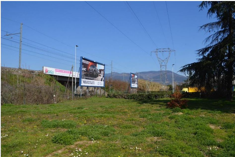
Figura 243 – Vista dell'area verde e del rilevato ferroviario
