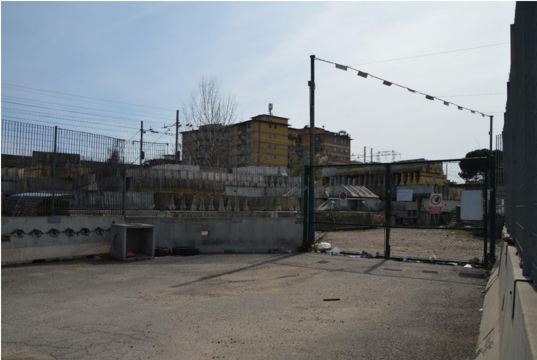
Figura 29 – Area destinata a deposito
