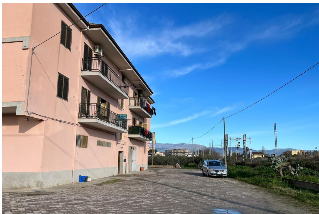
Figura 2 Foto esterno fabbricato
