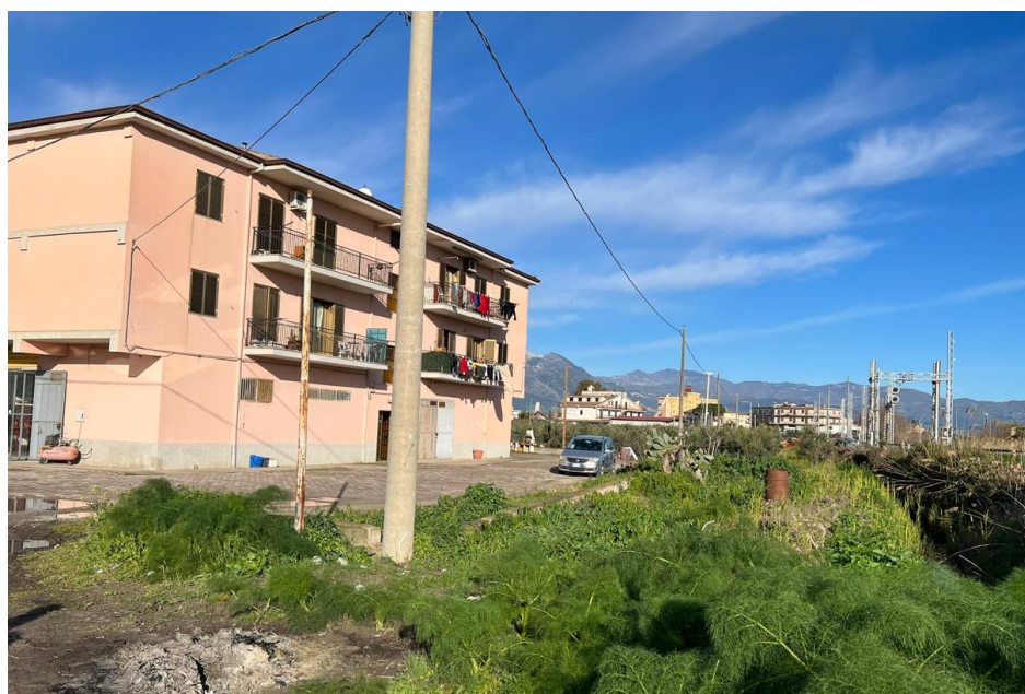
Figura 3 Foto esterno fabbricato
