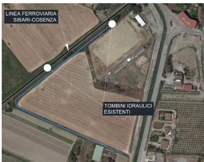
Figura 3 Inquadramento del canale esistente. A sinistra in alto: inquadramento planimetrico del canale esistente; a sinistra in basso: tombino idraulico esistente relativo al bacino A; a destra in basso: tombino idraulico esistente relativo al bacino B.
