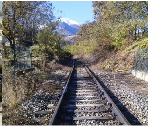
Impianto lubrificazione P.A.L. Italia (Foto: P.A.L. Italia; 2012)
