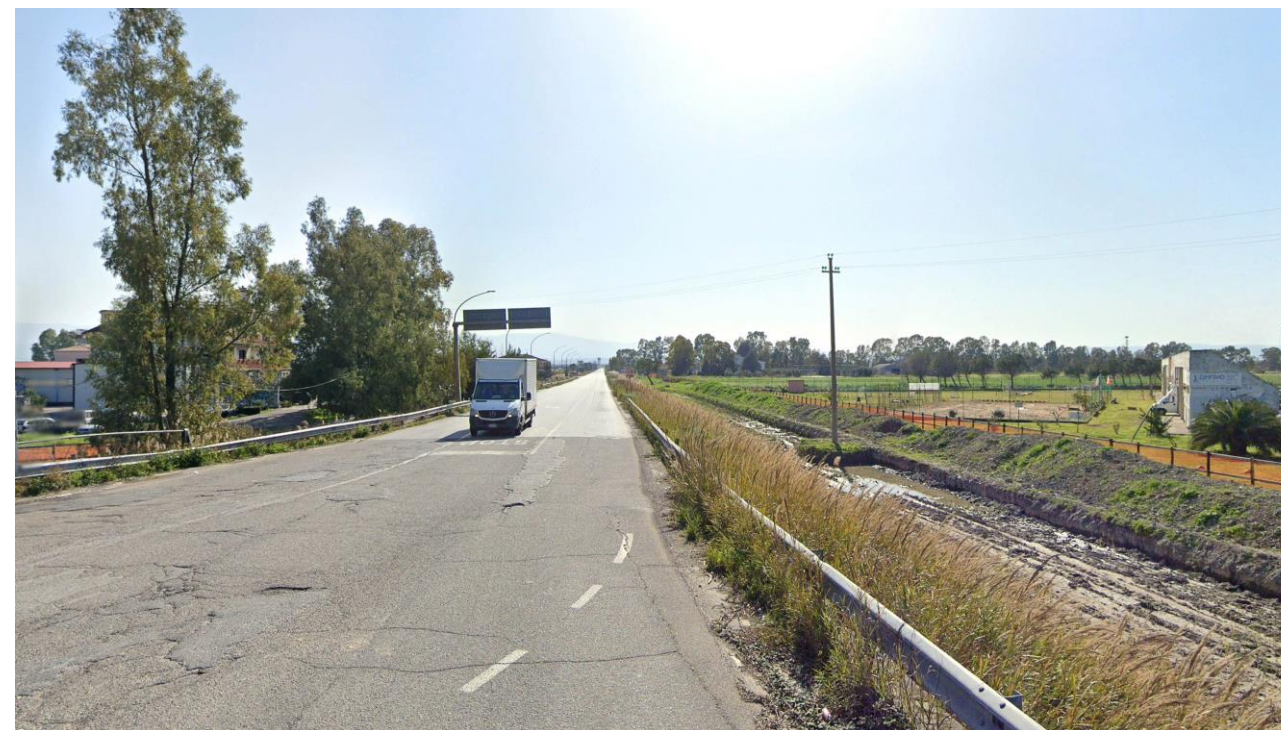
Figura 5-7 Condizioni percettive ante operam. SS106 Ionica – Punto di vista da nord
