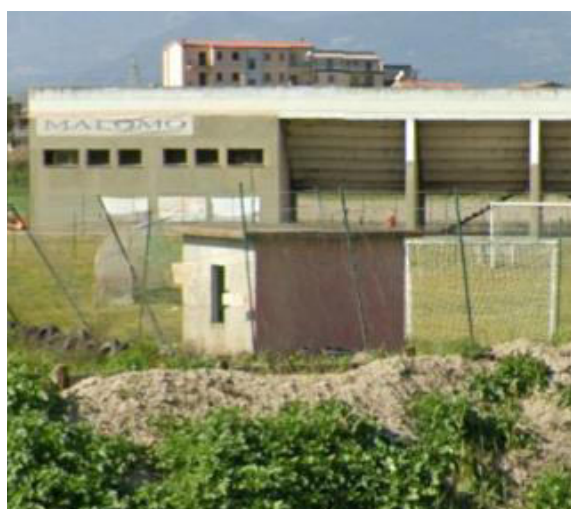
Figura 7-3 Fabbricato da demolire
