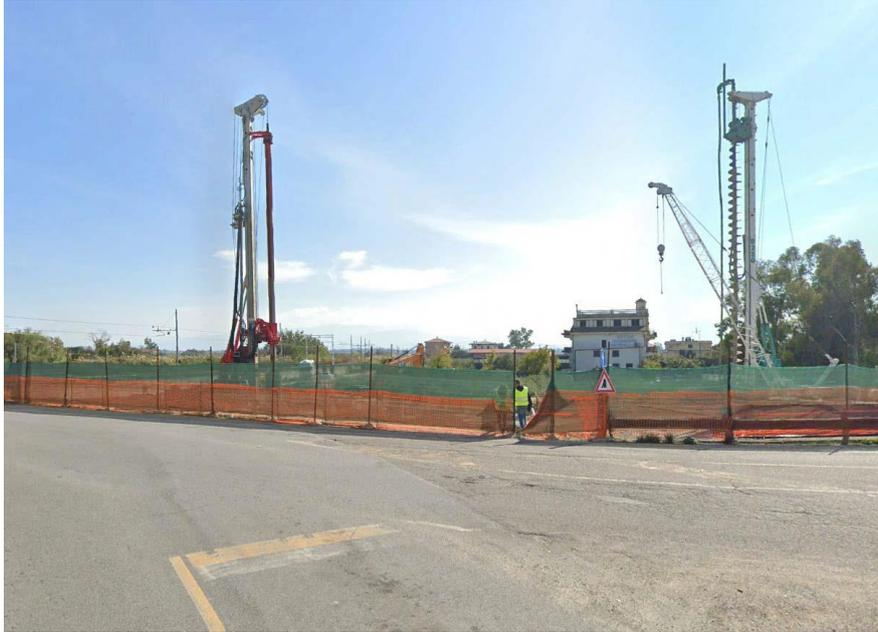
**Figura 9** – Lavori in corso per la soppressione del passaggio a livello, nella porzione settentrionale dell’area del survey.
