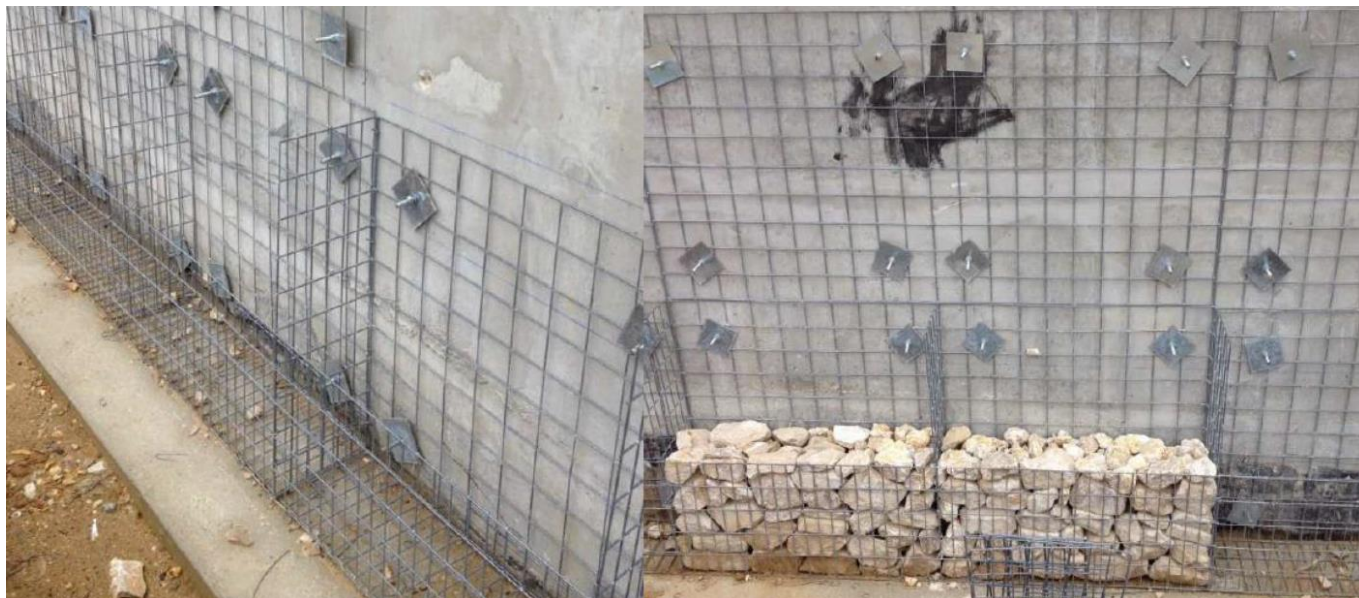
Figura 4 - Tipologico muro a gabbioni
