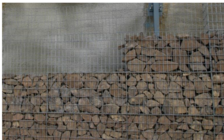
Figura 5 - Tipologico muro a gabbioni
