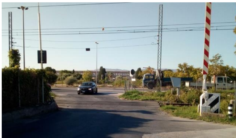
Foto 4 - Vista del passaggio a livello sulla linea storica per l'accesso al cantiere
