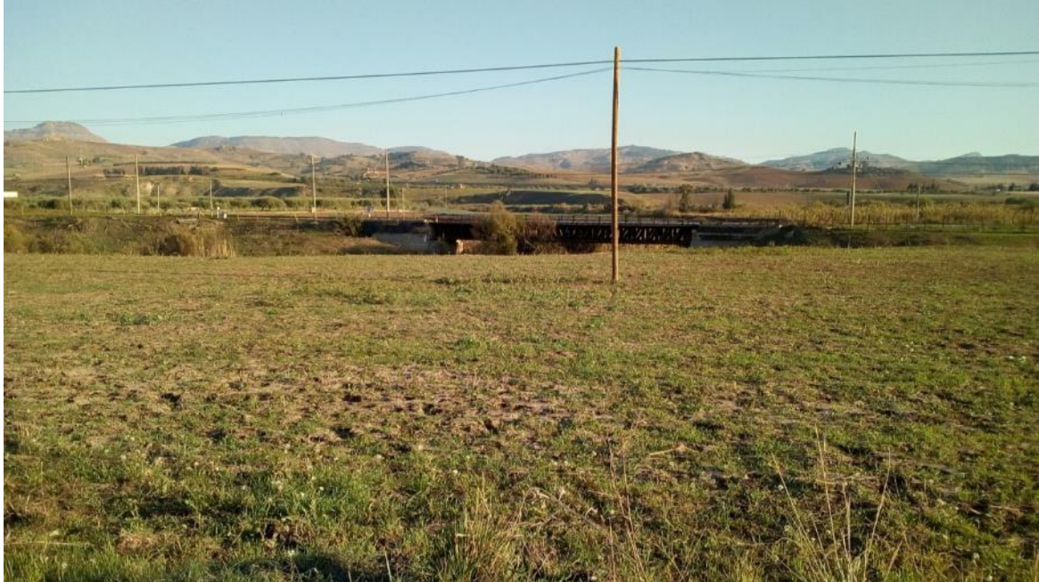
Foto1 - Vista del cantiere AT.12 (fonte sopralluogo)
