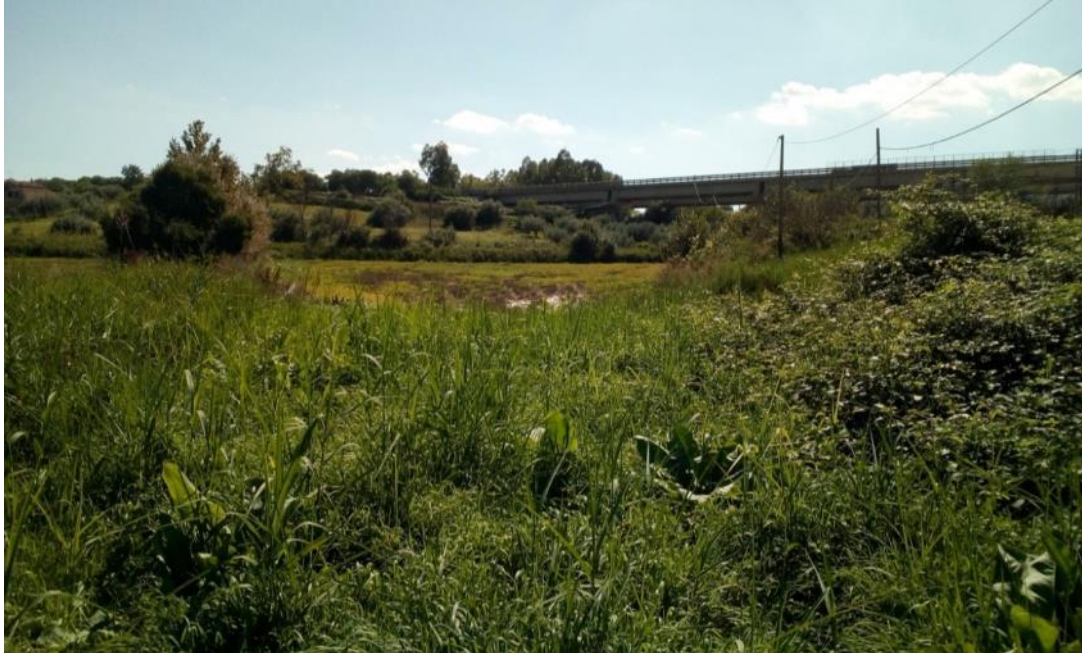
Foto1 - Vista del cantiere AS.01 (fonte sopralluogo)
