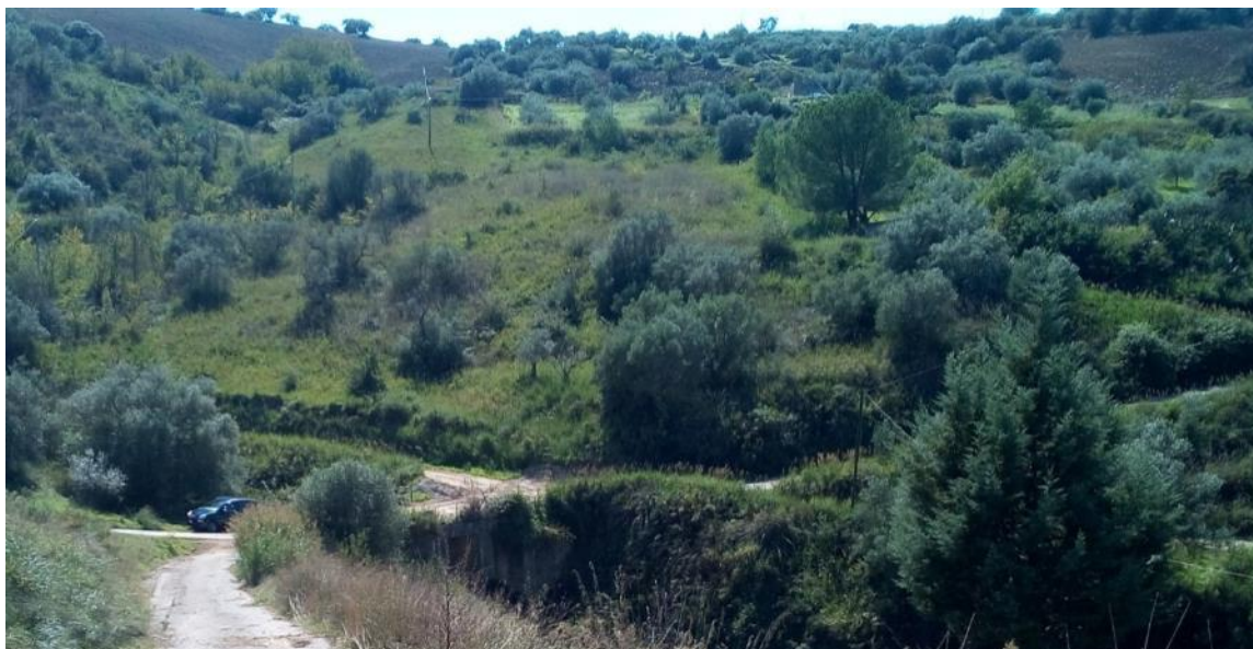
Foto1 - Vista dell'area di cantiere AT.04 (fonte sopralluogo)
