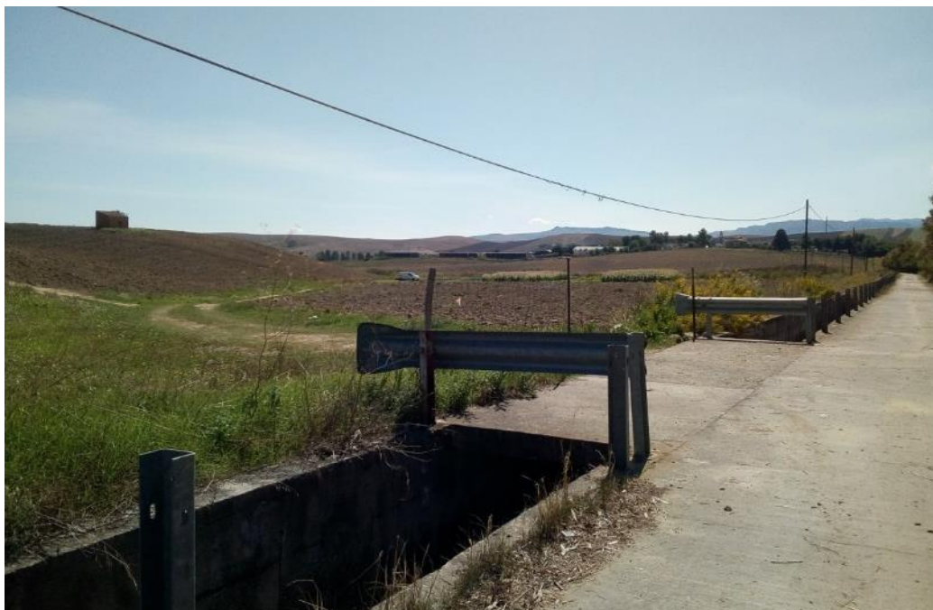
Vista della pista per l'uscita dal cantiere AT.06 (fonte sopralluogo)
