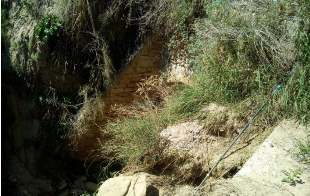
Vista del ponticello esistente (fonte sopralluogo)
