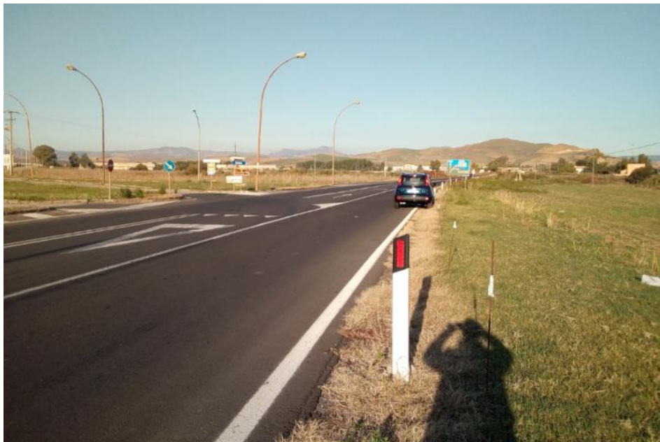
Foto2 - Vista dalla SS192 della zona di accesso all'area di cantiere (in dx) (fonte sopralluogo)
