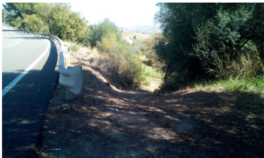
Vista dall'accesso al cantiere AT.13 (fonte sopralluogo)
