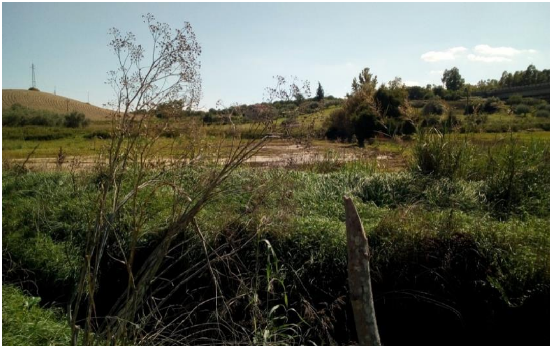
Foto2 - Vista del cantiere AS.06 (fonte sopralluogo)
