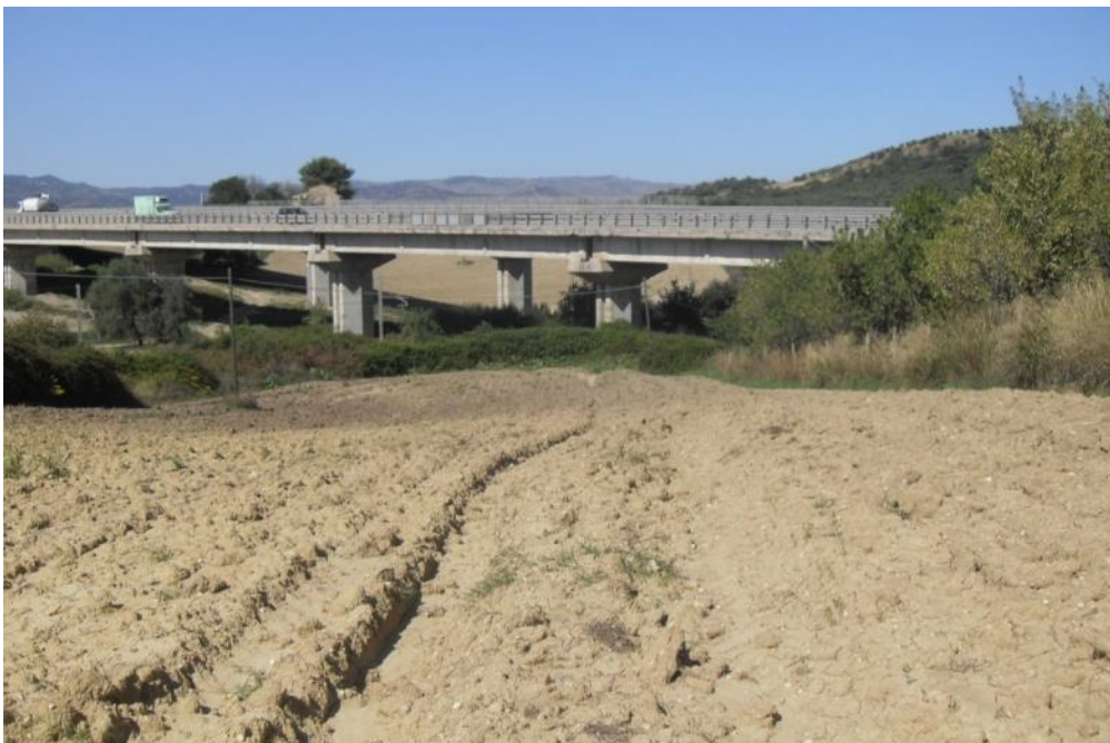
Foto1 - Vista del cantiere AT.02
