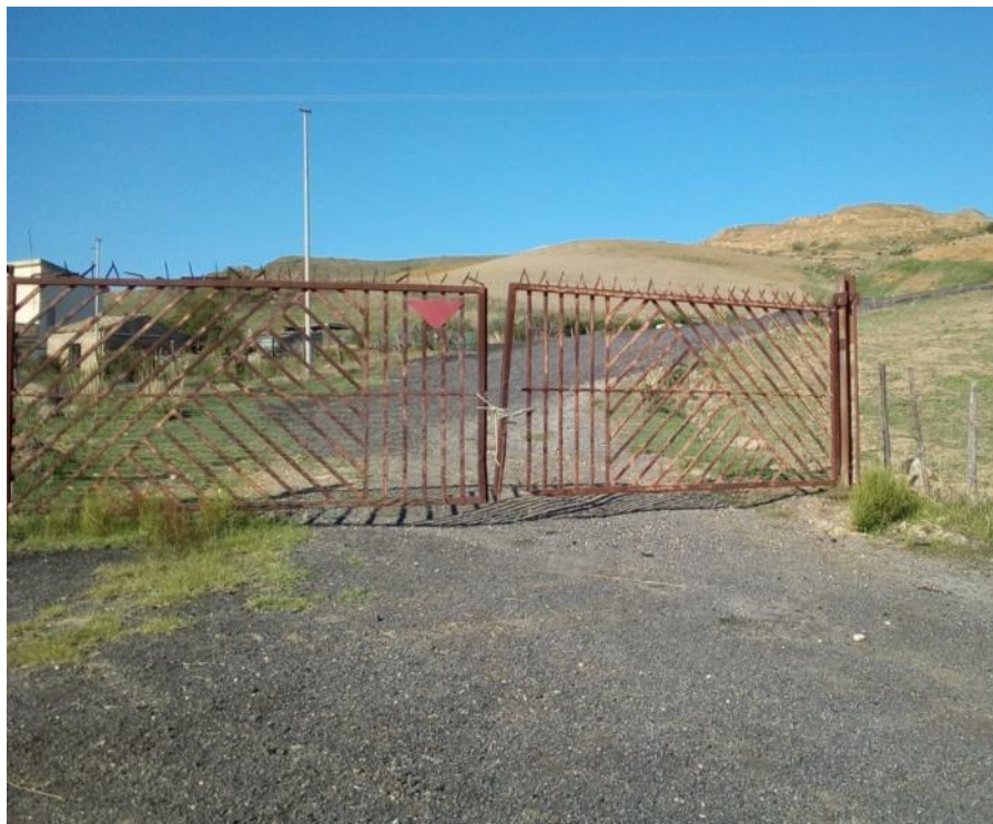
Strada privata interferente con l'imbocco della galleria Dittaino (fonte sopralluogo)
