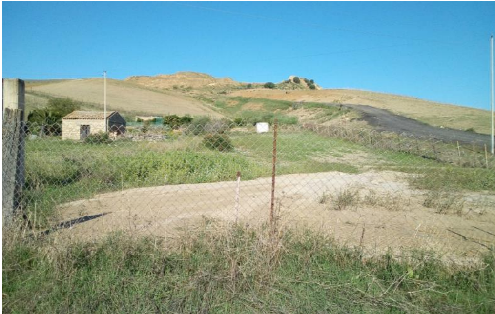
Foto1 - Vista del cantiere AT.10 (fonte sopralluogo)
