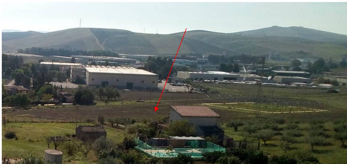
Foto 1 - Vista del cantiere CO.04 (fonte sopralluogo)
