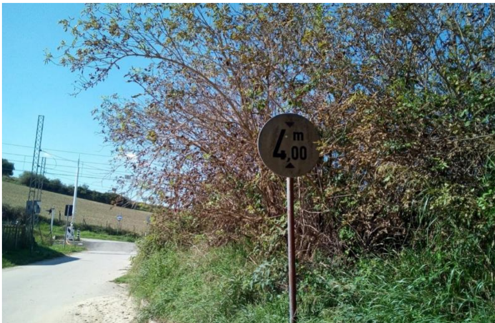
Vista del PL sulla linea storica e indicazione della limitazione per i cavi della TE
