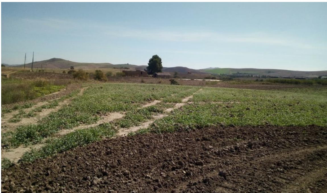
Foto1 - Vista del cantiere AS.02
