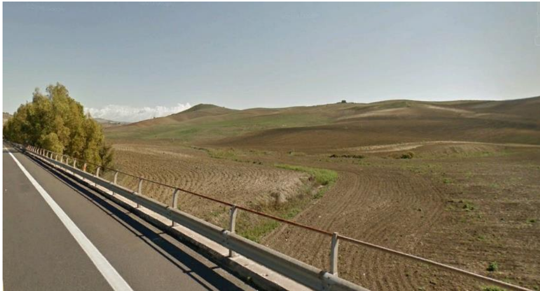
Foto 1 - Vista del cantiere AT.08 (fonte google Street View)
