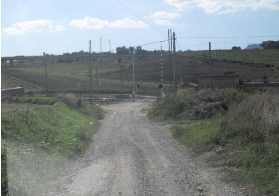
Vista del passaggio a livello sulla strada comunale che immette sulla SP95
