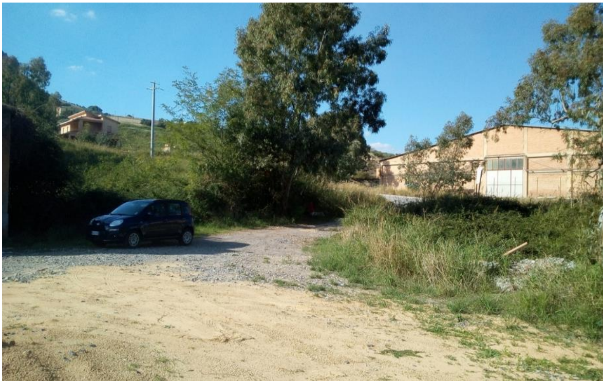
Vista dell'accesso all'area di cantiere (fonte sopralluogo)
