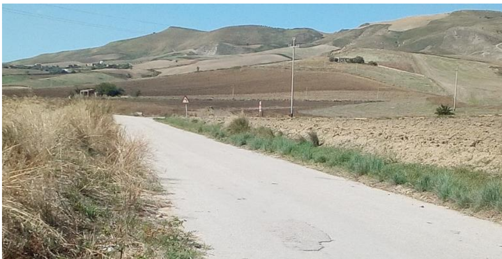
Vista della SP62 per l'accesso all'area di cantiere CO.02(fonte sopralluogo)
