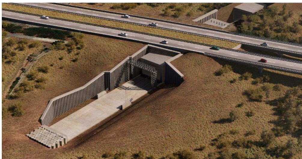
Figura 3 Soluzione migliorativa proposta, sottoattraversamento dell'autostrada A19
