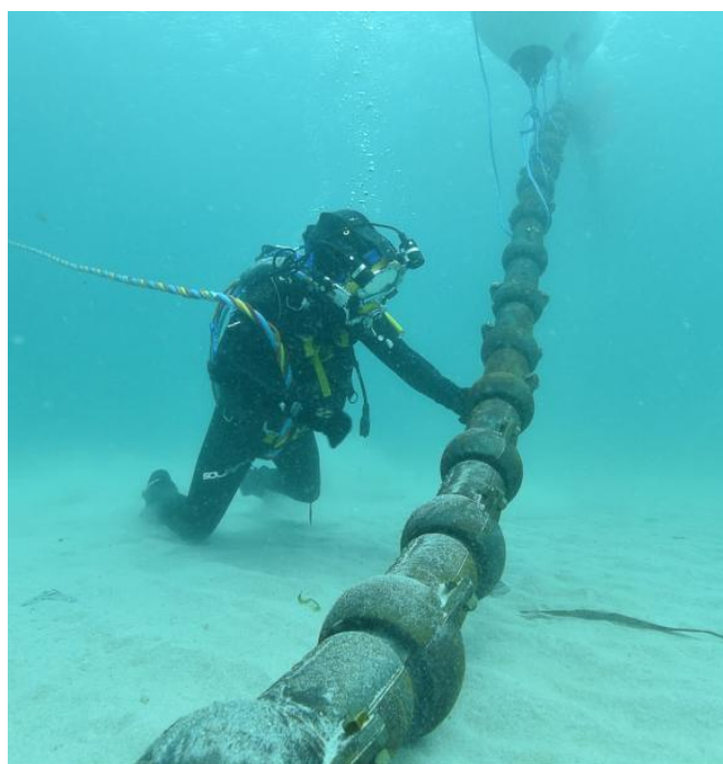
Figura 4-12: Esempio di metodo di posta con gusci di protezione
