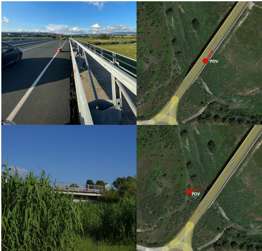
Figura 3.3 Vista dell'attraversamento del fiume Fine lungo Via per Rosignano
