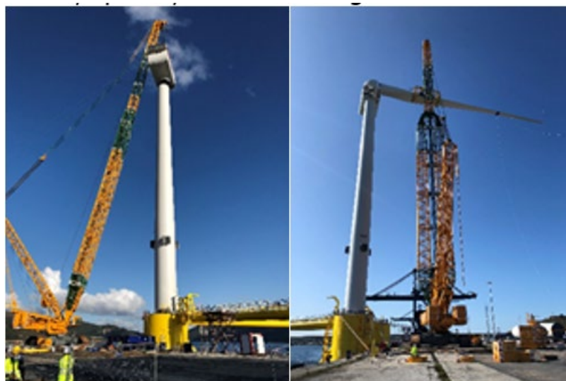
Figura 2.19 Installazione di una turbina eolica
