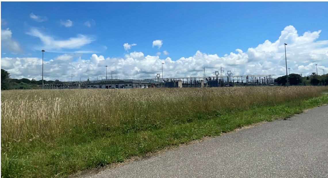
Figura 2.13 Visuale della stazione elettrica “Roselectra” di Rosignano Marittimo (LI) – P11
