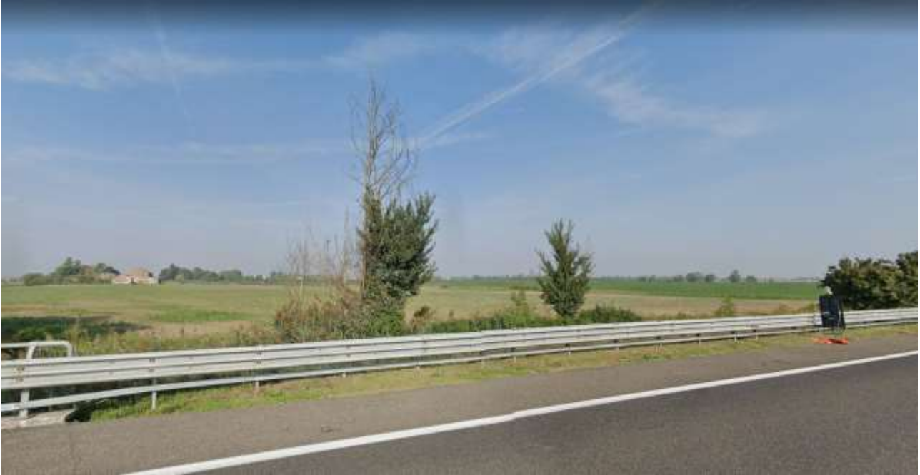
STATO attuale, vista da Autostrada A13 (ovest)
