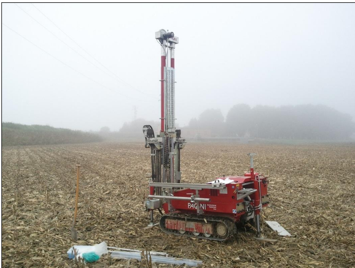
Esempio esecuzione sondaggio a carotaggio continuo
