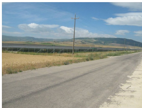
Foto 8 - Uno scorcio del grande Parco fotovoltaico di Troia
