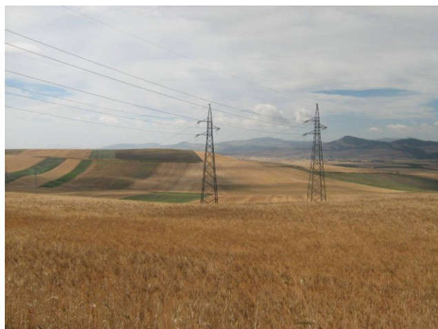
Foto 10 - Seminativi attraversati da un tratto dell'elettrodotto esistente
