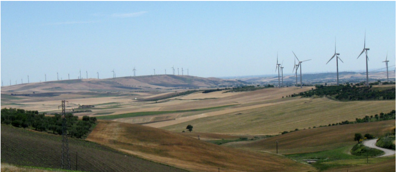
Foto 4 - Numerosi aerogeneratori in prossimità del tracciato
