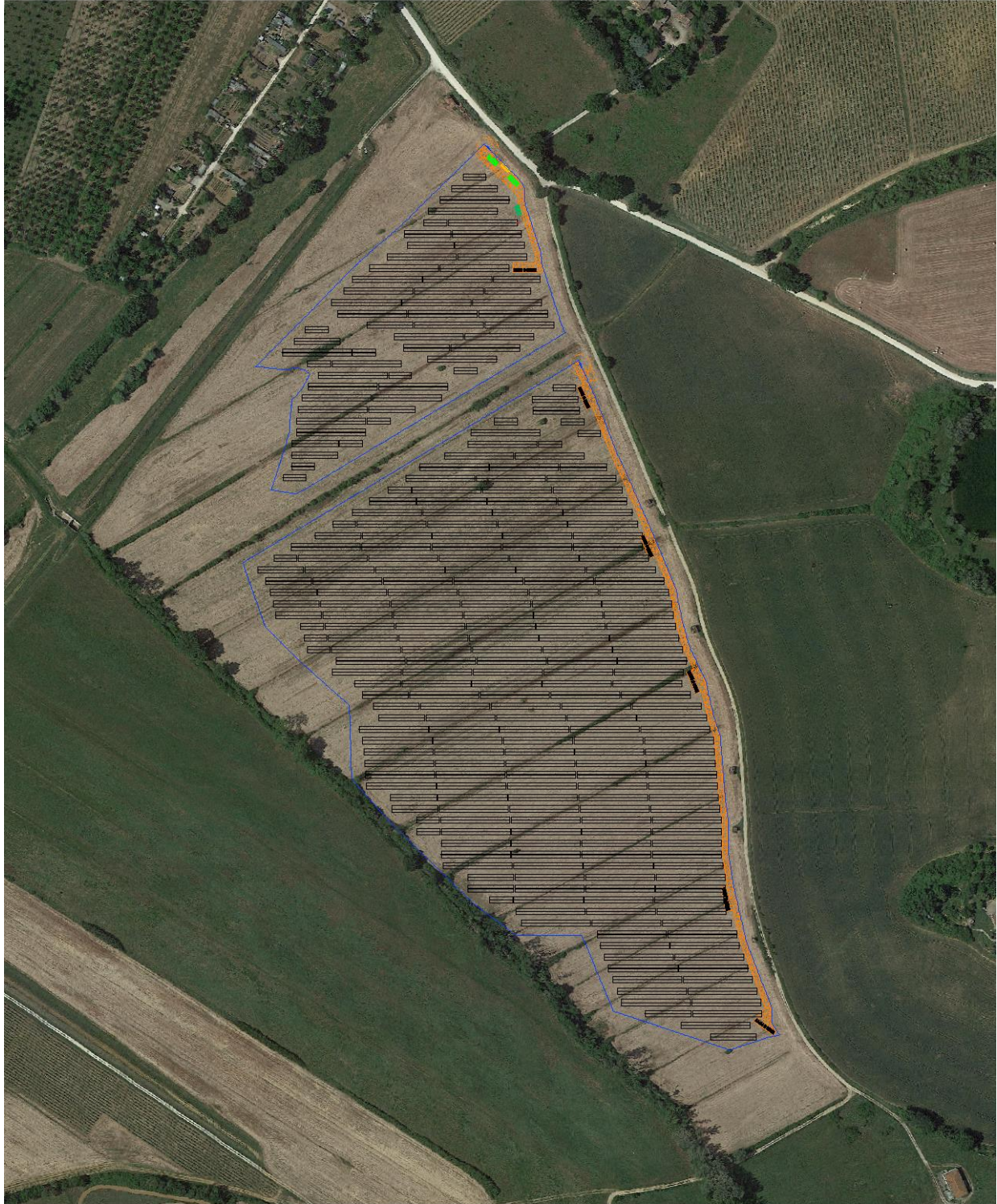
Figura 1.6: Impianto Fotovoltaico su Ortofoto
