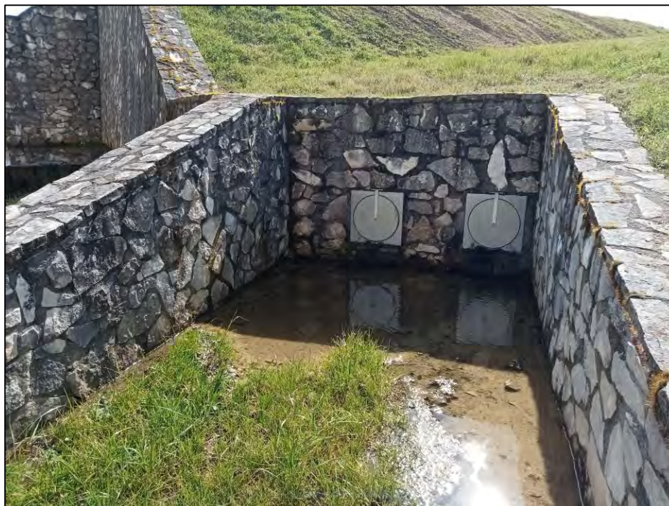
Figura 2.14: Sopralluogo nell'area di ubicazione dell'impianto, posizione 3: dettaglio manufatto di uscita degli scarichi di fondo con valvole a 'clapet' di non ritorno, vista da valle verso monte
