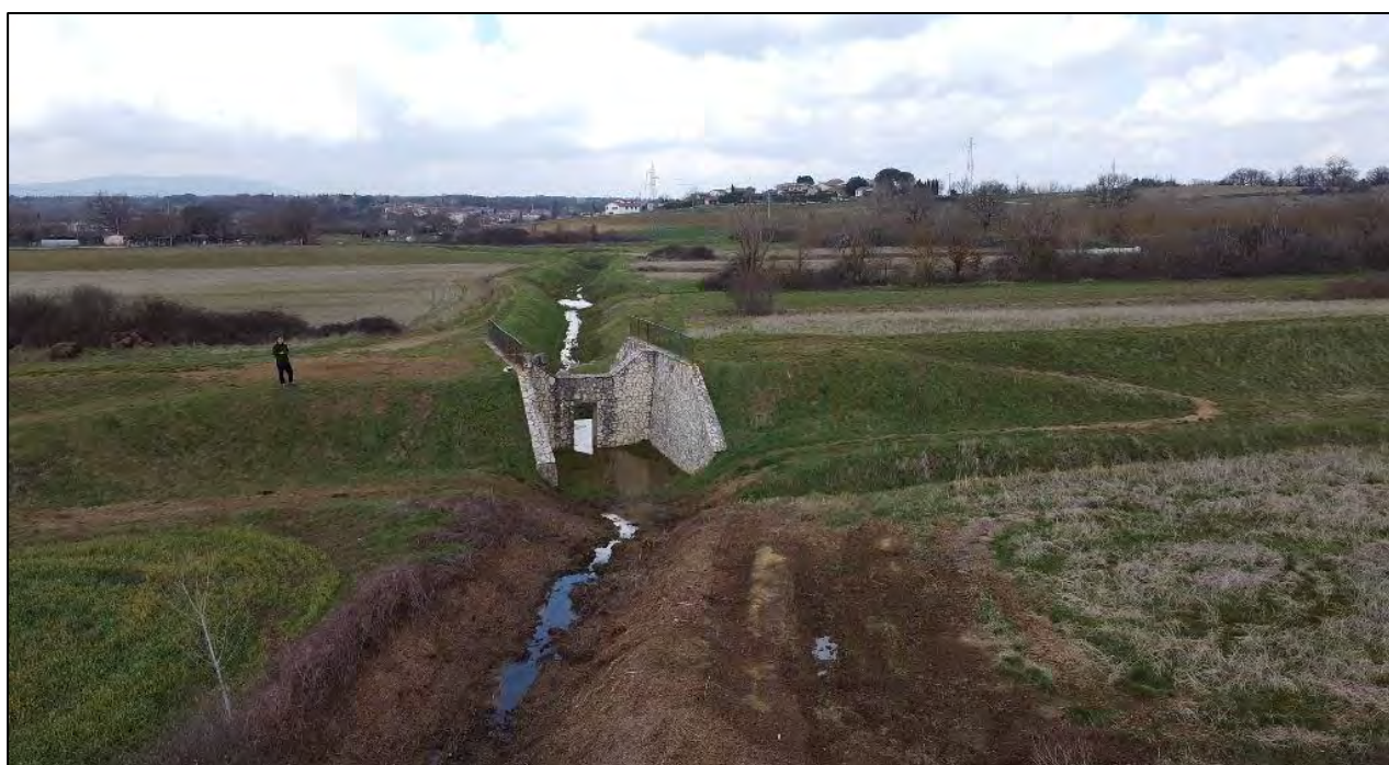
Figura 2.11: Sopralluogo nell'area di ubicazione dell'impianto, posizione 1: sezione defluente del Torrente di Scarna in prossimità dell'opera di regolazione in linea delle portate, vista da monte verso valle, scatto aereo da drone. Si intuisce l'altezza non trascurabile dei profili delle arginature perimetrali di contenimento dei volumi della cassa di laminazione
