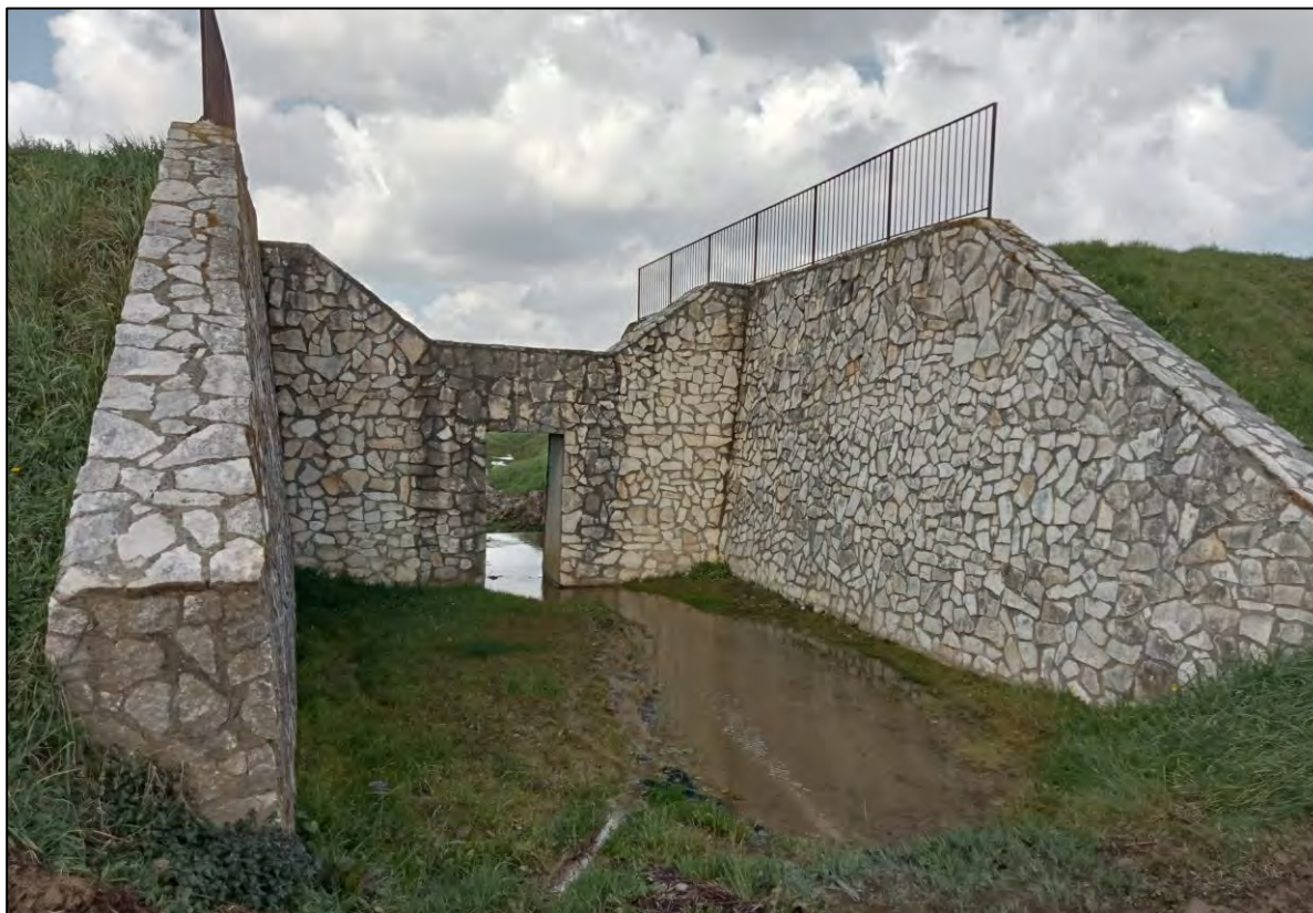
Figura 2.12: Sopralluogo nell'area di ubicazione dell'impianto, posizione 2: dettaglio dell'opera di regolazione in linea delle portate, vista da monte verso valle. Si nota la luce di fondo rettangolare e la gaveta trapezoidale di sfioro
