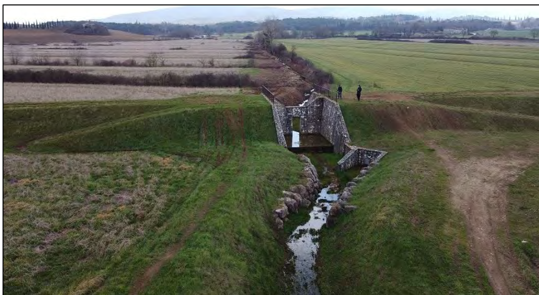
Figura 2.17: Sopralluogo nell'area di ubicazione dell'impianto, posizione 6: sezione defluente del Torrente di Scarna a valle dell'opera di regolazione in linea delle portate, vista da valle verso monte, scatto aereo da drone. Si nota il manufatto d'uscita degli scarichi di fondo e la sezione defluente del torrente a valle della cassa di espansione
