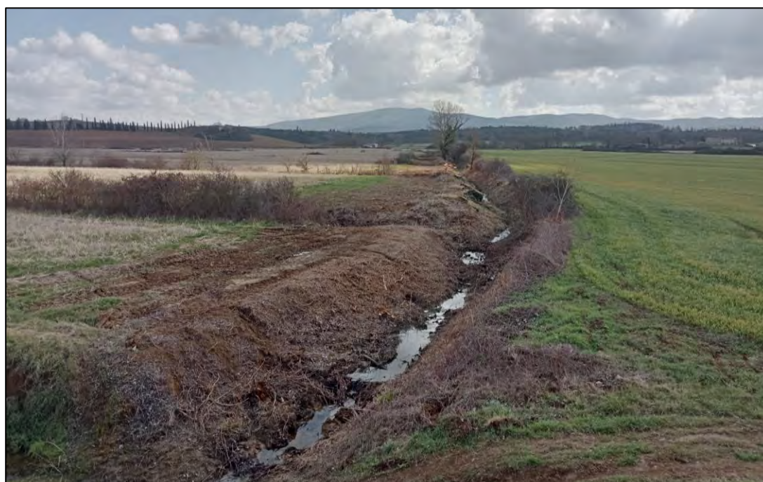
Figura 2.9: Sopralluogo nell'area di ubicazione dell'impianto, posizione 1: sezione defluente del Torrente di Scarna in prossimità dell'opera di regolazione in linea delle portate, vista da valle verso monte. Si notano le probabili recenti operazioni di pulizia e sfalcio dalla vegetazione
