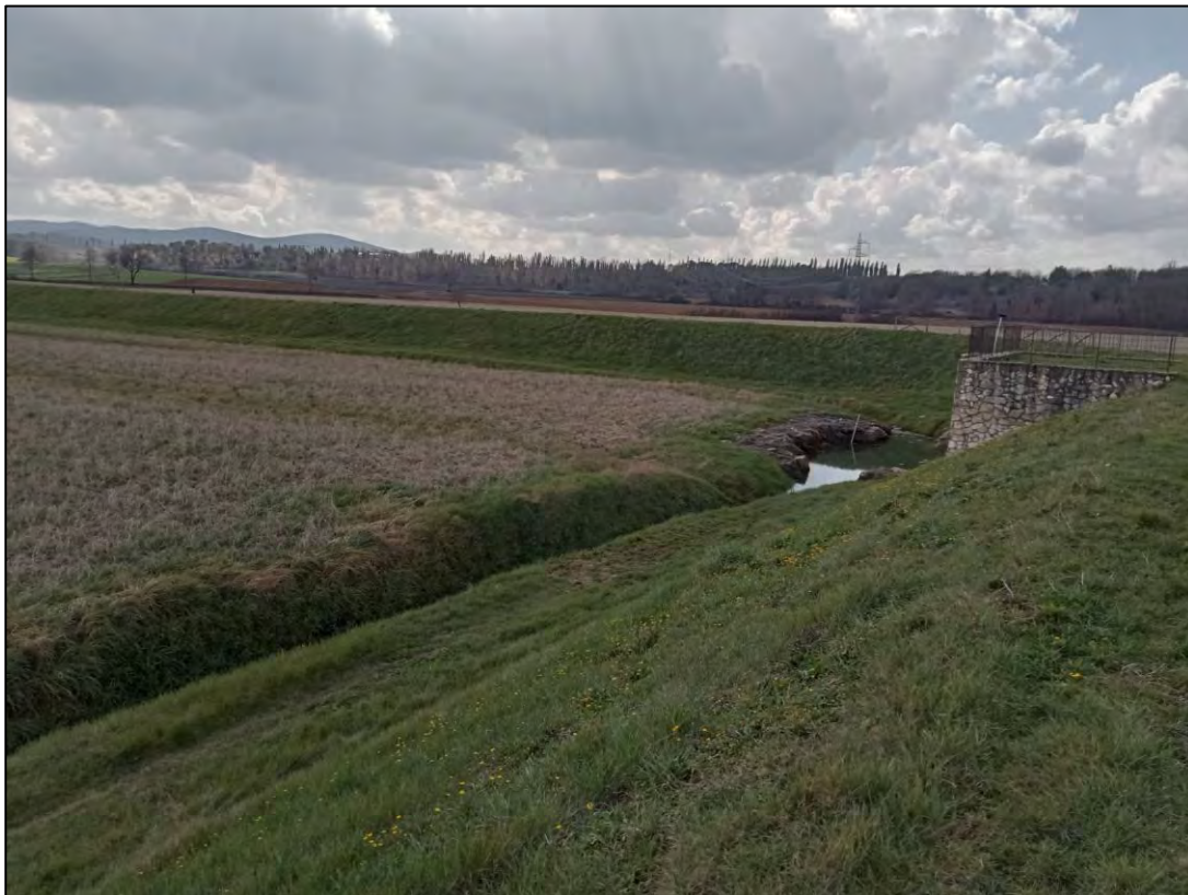
Figura 2.16: Sopralluogo nell'area di ubicazione dell'impianto, posizione 5: dettaglio pendenza morfologica della cassa di espansione in direzione del manufatto d'ingresso degli scarichi di fondo, con saracinesche ad azionamento manuale, posto all'angolo nord-ovest dell'area adibita a cassa di laminazione, altimetricamente più depressa
