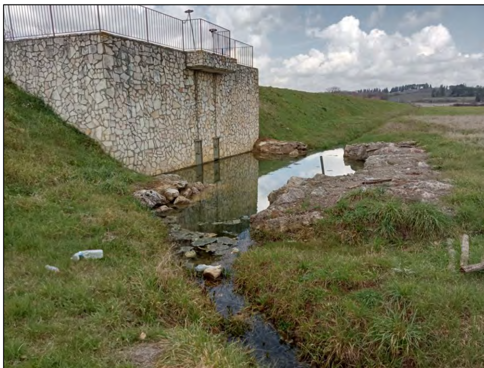
Figura 2.15: Sopralluogo nell'area di ubicazione dell'impianto, posizione 4: dettaglio manufatto d'ingresso degli scarichi di fondo, con saracinesche ad azionamento manuale, posto all'angolo nord-ovest dell'area adibita a cassa di espansione, altimetricamente più depressa
