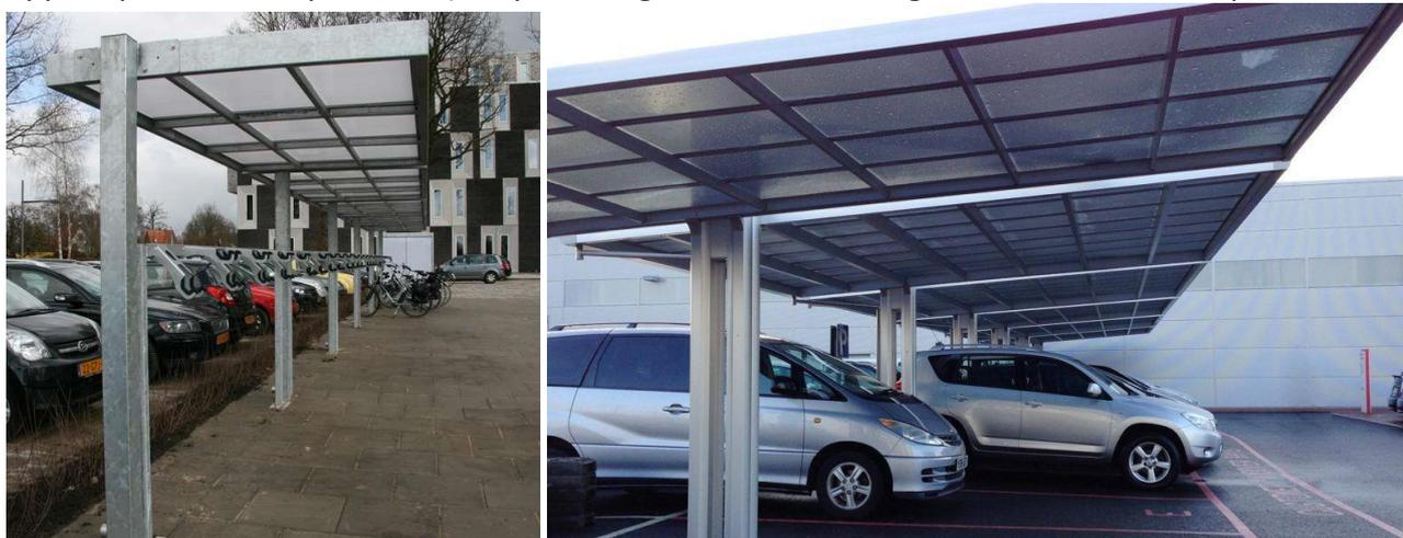
**Figura 5: possibile riutilizzo dei tracker come sostegni per pensiline con o senza pannelli solari (Fonte: immagine a sinistra: <https://www.falco.co.uk/>; immagine a destra: <https://www.canopiesuk.co.uk/>)**
