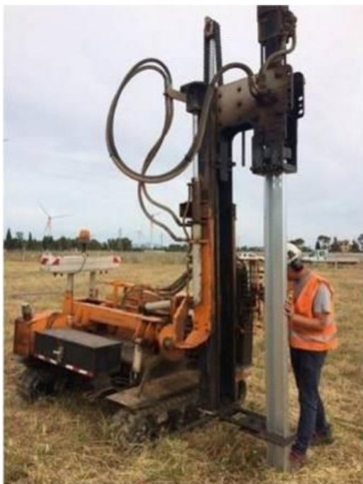
Figura 2. Esempio di supporto costituito da palo in acciaio infisso direttamente nel terreno mediante battipalo.
