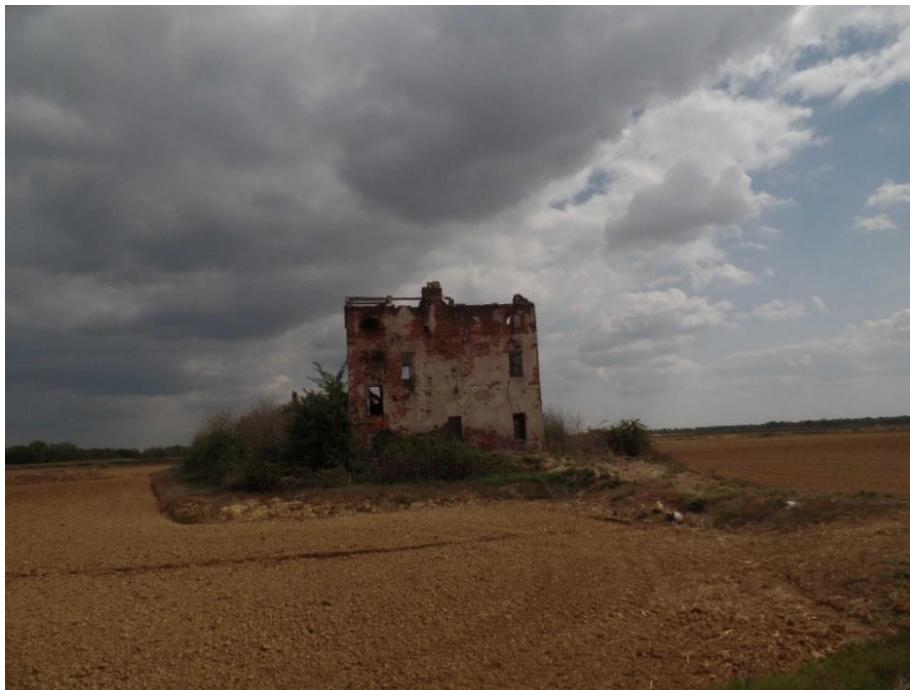
Figura 38. Visuale dell'edificio parzialmente diroccato situato nel settore centro-occidentale dell'area di intervento.
