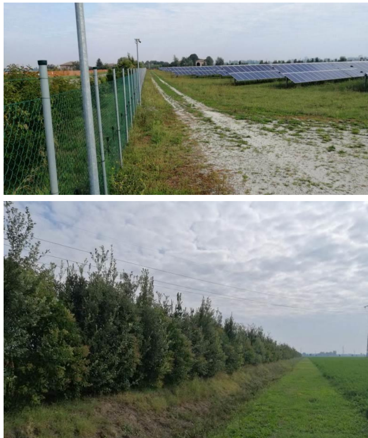
Figura 53. Esempio di realizzazione di un impianto fotovoltaico senza fondazioni in cls e senza impermeabilizzazione del suolo, con schermatura perimetrale mediante siepi arbustive (scelte progettuali analoghe a quelle adottate per l'impianto in esame)
