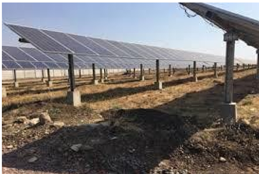
Figura 62 Esempio di impianto fotovoltaico con fondazioni ottenute mediante perforazione del terreno e successiva creazione del palo
