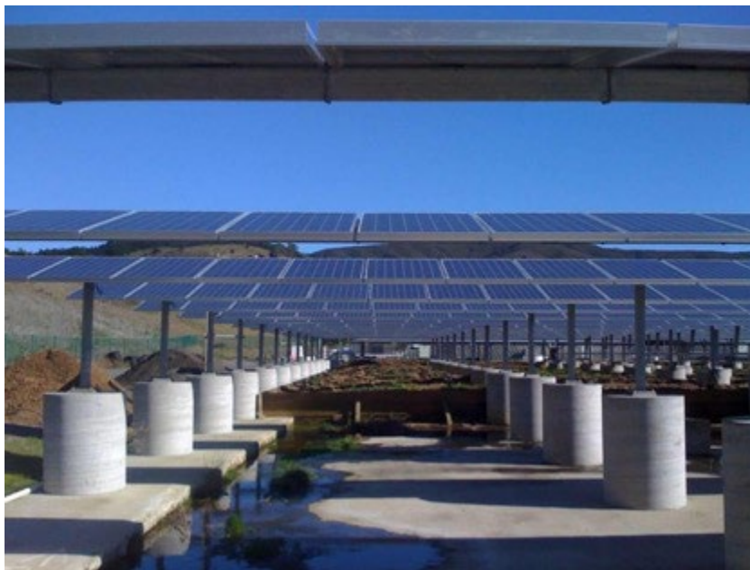
Figura 63 Esempio di impianto fotovoltaico con fondazioni formate da zavorre costituite da plinti in cemento
