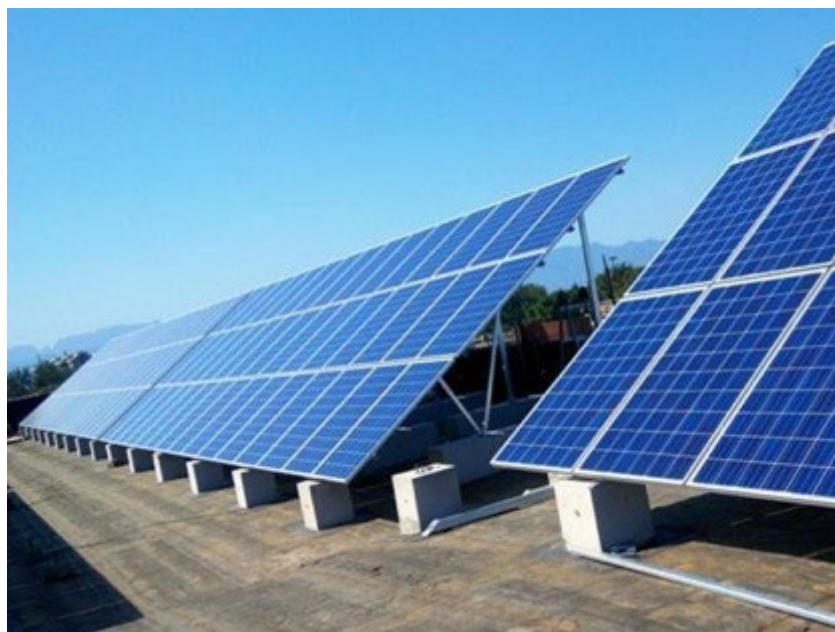
Figura 64 Esempio di impianto fotovoltaico con fondazioni formate da zavorre costituite da plinti in cemento
