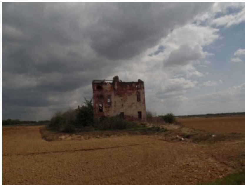
Figura 28 Visuale dell'edificio parzialmente diroccato situato nel settore centro-occidentale dell'area di intervento.
