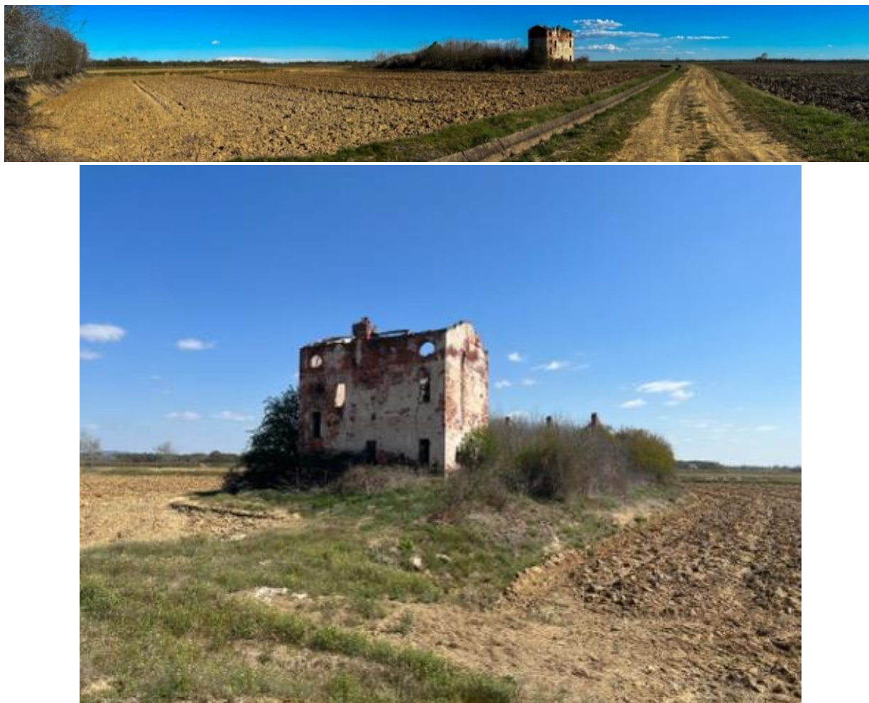
Figura 47. Fotografie dell'edificio parzialmente diroccato all'interno dell'area di intervento e parzialmente colonizzato da vegetazione pioniera (rispettivamente foto 9 e 10 dell'inquadramento dell'area di impianto).
