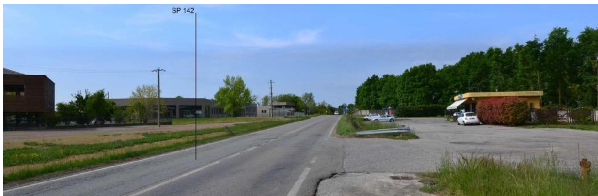
Foto 15 – Panoramica in direzione ovest, verso l'area di progetto della cabina di connessione, dalla SP 142. L'area di progetto, posta ad oltre 270 metri di distanza, non risulta visibile.
