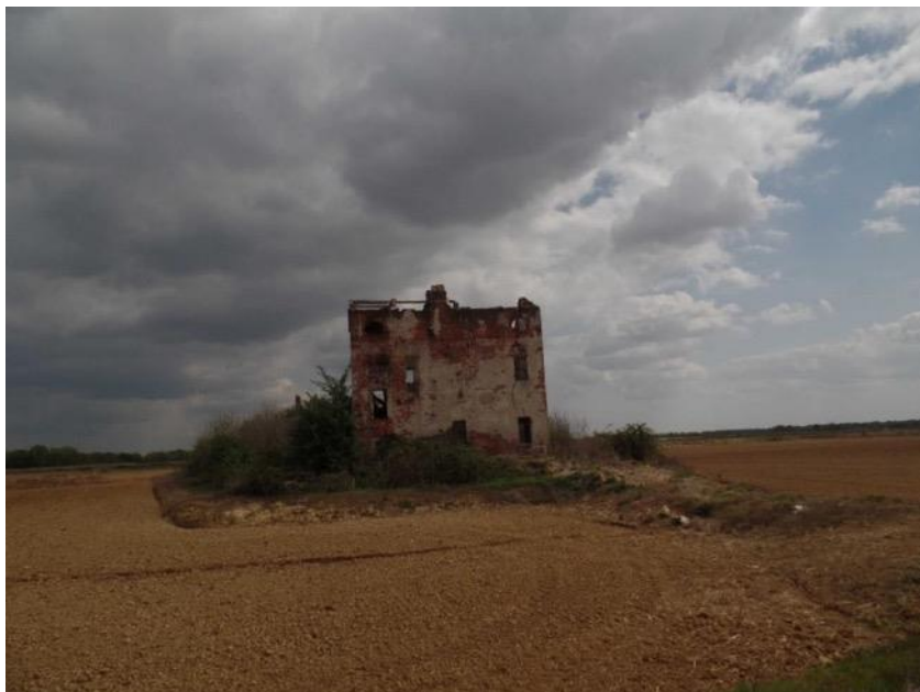
Figura 15. Visuale dell'edificio parzialmente diroccato situato nel settore centro-occidentale dell'area di intervento.
