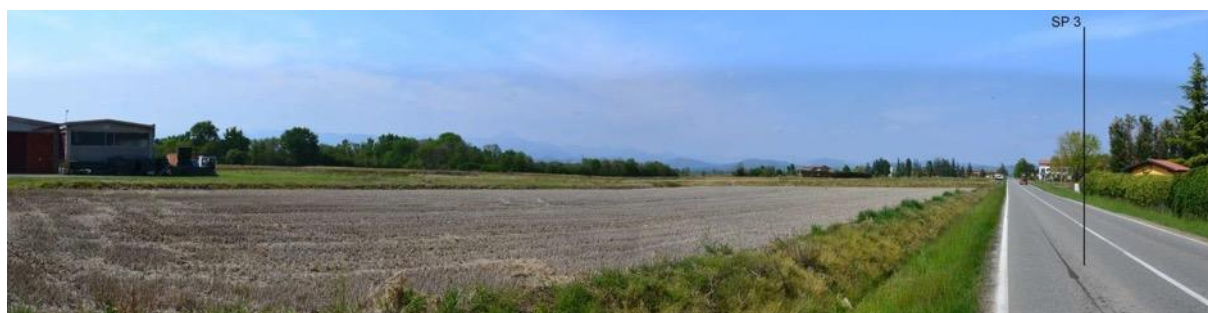
Foto 46 – Panoramica in direzione nord-ovest, verso le aree di progetto, dal margine urbano dell'abitato di Rovasenda lungo la SP 3. Le aree di progetto non risultano visibili.
