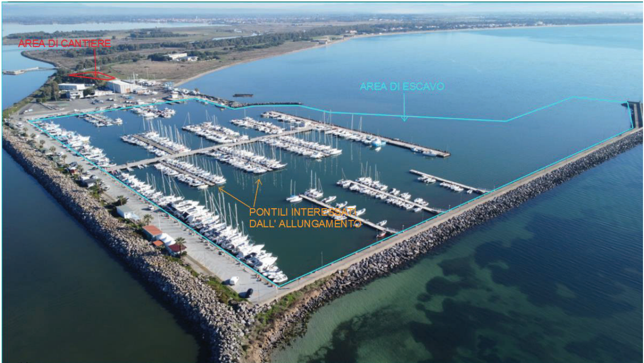
Figura 23 Vista aerea dal mare degli interventi da realizzare
