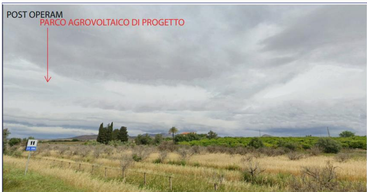
Figura 66: Ripresa fotografica da Belvedere nel comune di Ramacca - NON VISIBILE.
