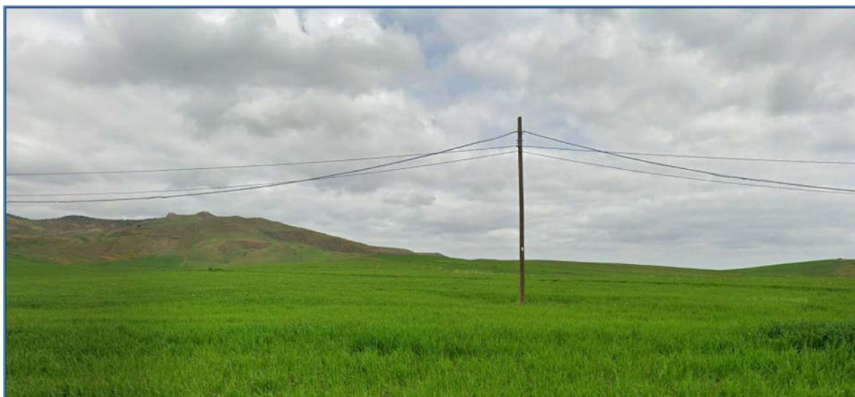
Figura 7: foto panoramiche dell'area dell'impianto
