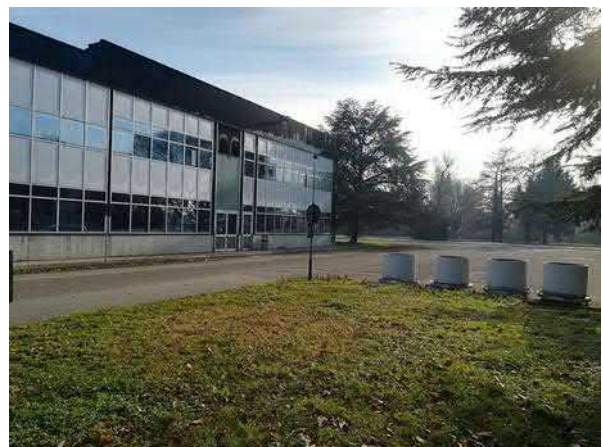
Figura 15 - Vista del Punto B
