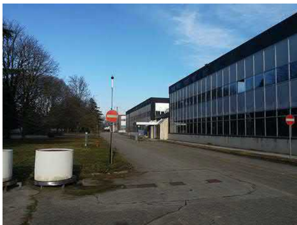
Figura 14 - Vista del Punto B
