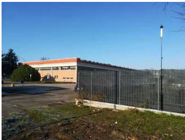
Figura 11 - Vista del Punto A
