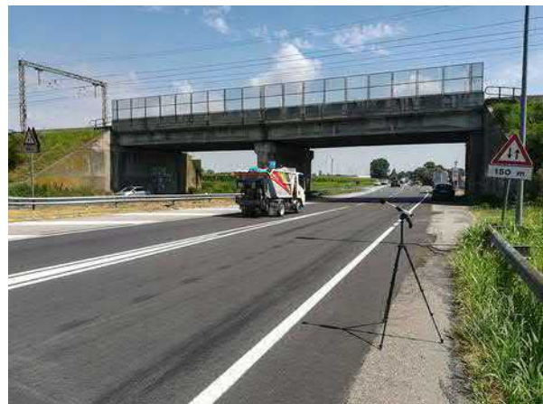
Figura 20 - Vista del Punto 02
