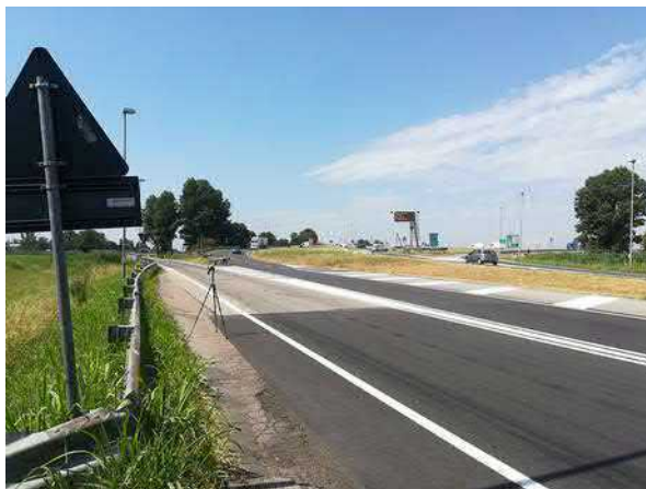
Figura 19 - Vista del Punto 02
