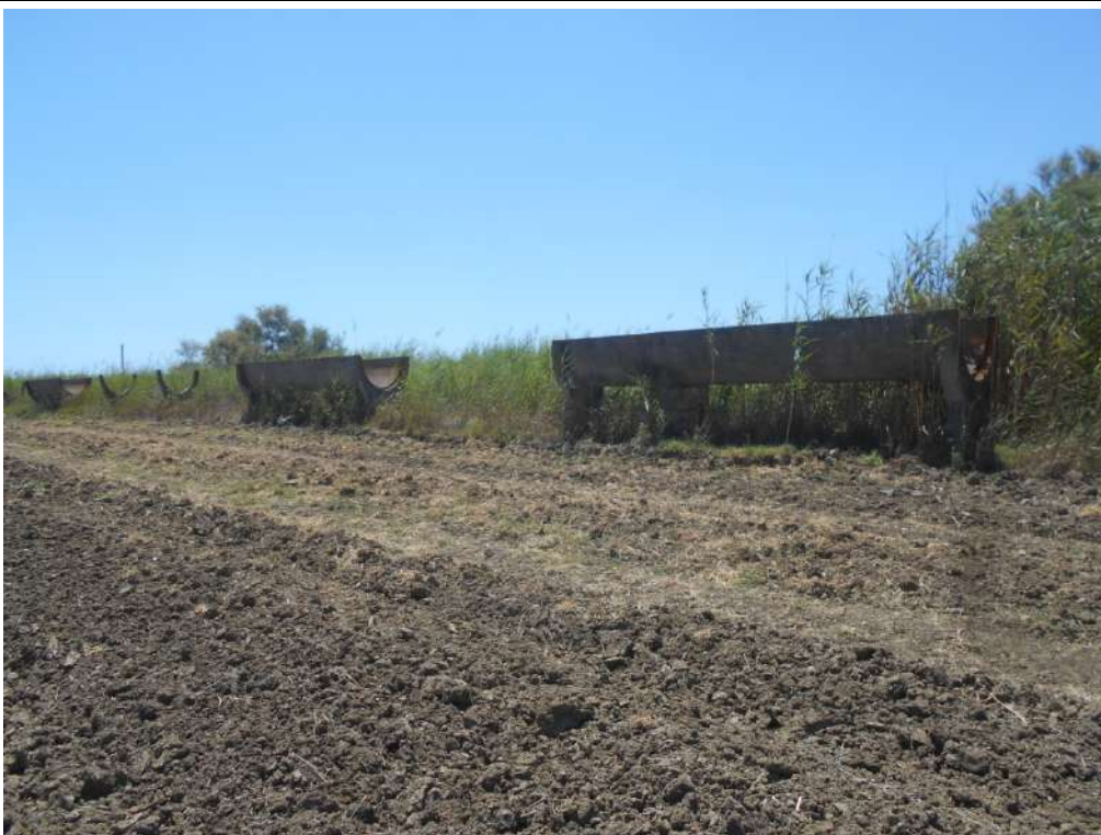
UR2 VISTA DA SUD. CAMPO ARATO E RESTI DI CANALI IRRIGUI IN CEMENTO.
