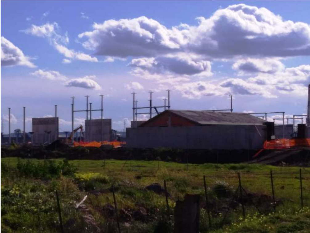
UR5 COSTRUENDA NUOVA STAZIONE ELETTRICA TERNA.
