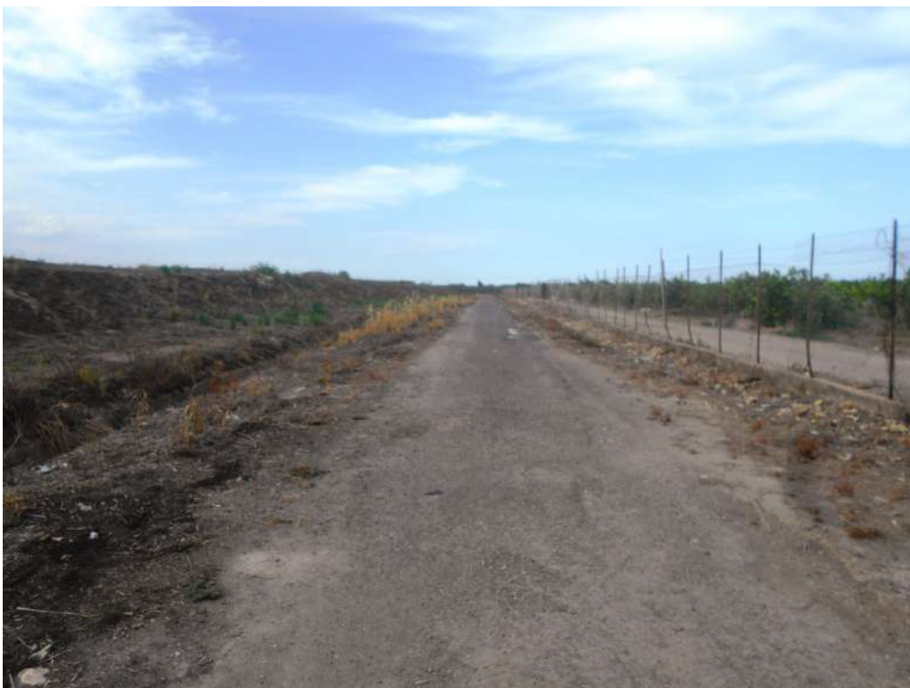
UR4 CAVIDOTTO INTERRATO SU VIABILITÀ PRIVATA IN TERRA BATTUTA LUNGO L'ARGINE FLUVIALE DESTRO DEL SIMETO (LOC.TÀ MANDRAZZE)
