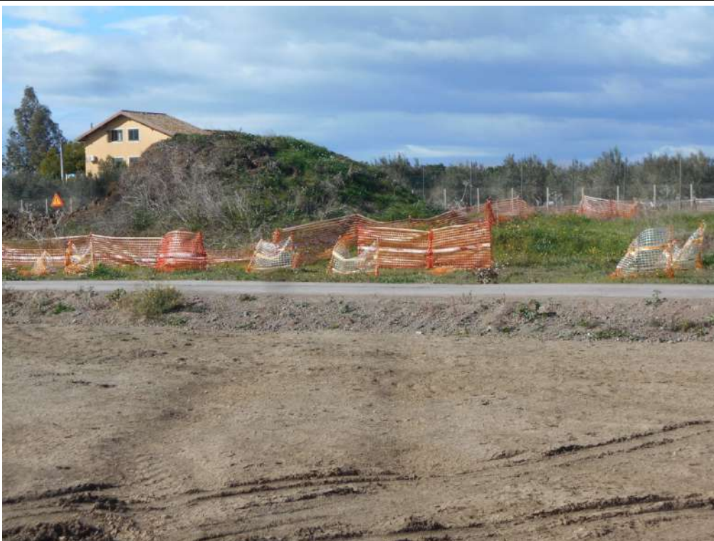
UR5 COSTRUENDA NUOVA STAZIONE ELETTRICA TERNA.
