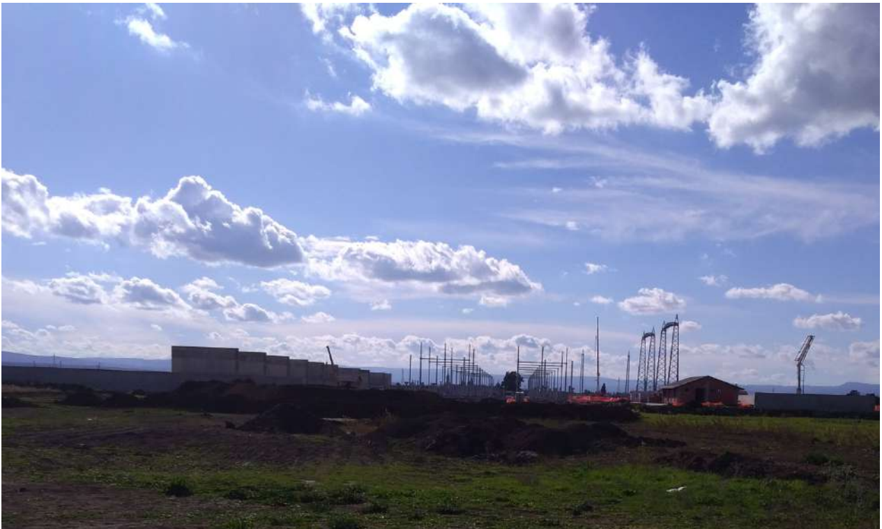
UR5 COSTRUENDA NUOVA STAZIONE ELETTRICA TERNA.
