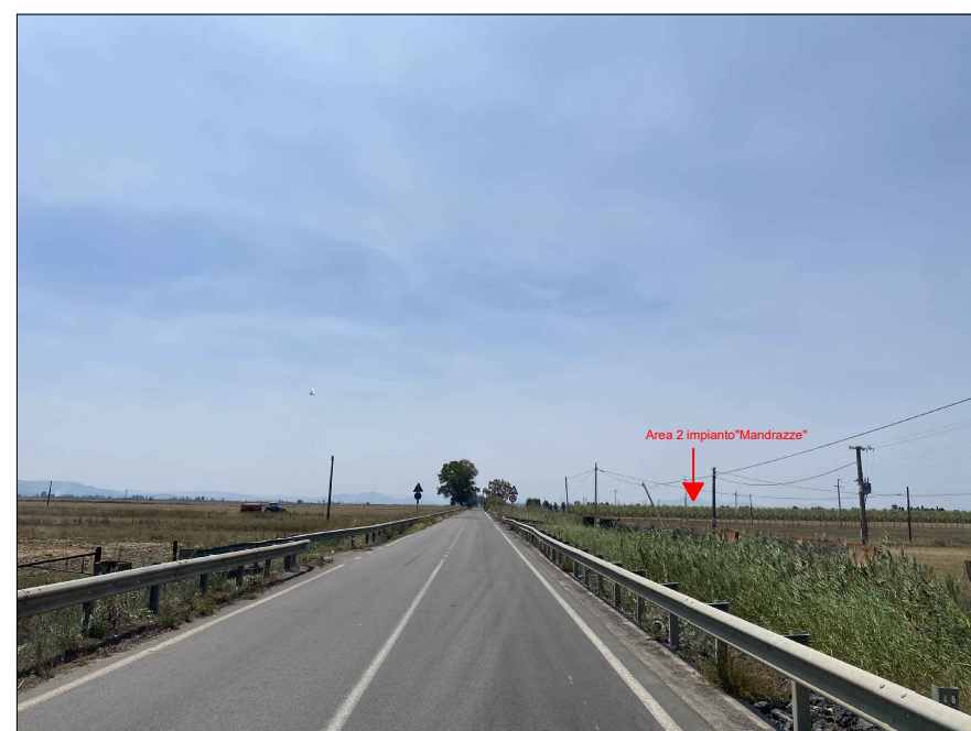
STRADA DI NORMALE ACCESSIBILITA' 2: SP69ii (VERSO OVEST) - POST OPERAM
