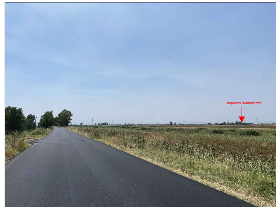
BENE ISOLATO 3: SP104 PROSSIMO A BENE ISOLATO_MASSERIA CASALINO - POST OPERAM
