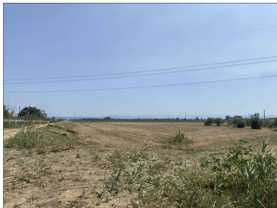
TRATTO PANORAMICO 1: SS 417 - ANTE OPERAM
